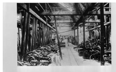
Intérieur de l'atelier de clouterie, photogr., s.n., s.d. [vers 1890-1900]. Phot. IVR43_19822500313V
