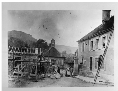
Construction de la conciergerie, photogr., s.n., s.d. [début 20e siècle]. Phot. IVR43_19822500289V
