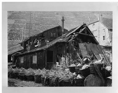
Atelier de "décaperie" du fil de fer, et stockage d'acide chlorydrique en bonbonnes, photogr., s.n., s.d. [avant 1903].
