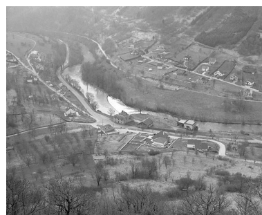
Vue générale de la tréfilerie Bersaillin. Phot. Yves Sancey IVR43_19822500317X
