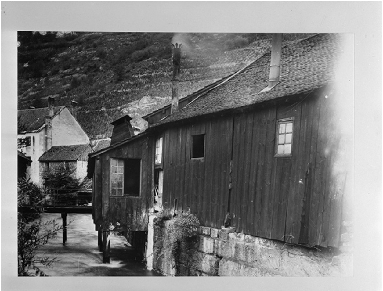
Façade postérieure du magasin à clous et de la menuiserie, fotogr., s.n., s.d. [avant 1903].
