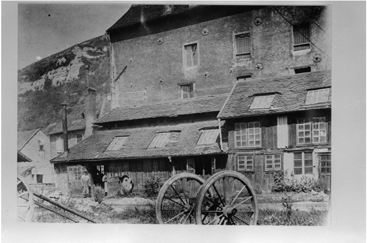
Atelier de clouterie devant le bâtiment du moulin, fotogr., s.n., s.d. [avant 1903].
