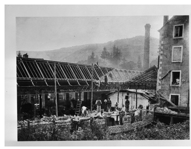
Construction du nouvel atelier de clouterie, photogr., s.n., s.d. [1904 ?].
