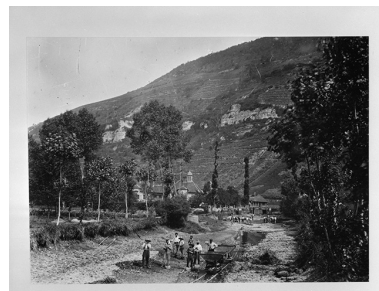
Curage du canal d'amenée, photogr., s.n., s.d. [début 20e siècle]. Phot. IVR43_19822500309V
