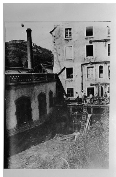
Travaux d'entretien du canal, photogr., s.n., s.d. [après 1903]. Phot. IVR43_19822500296V
