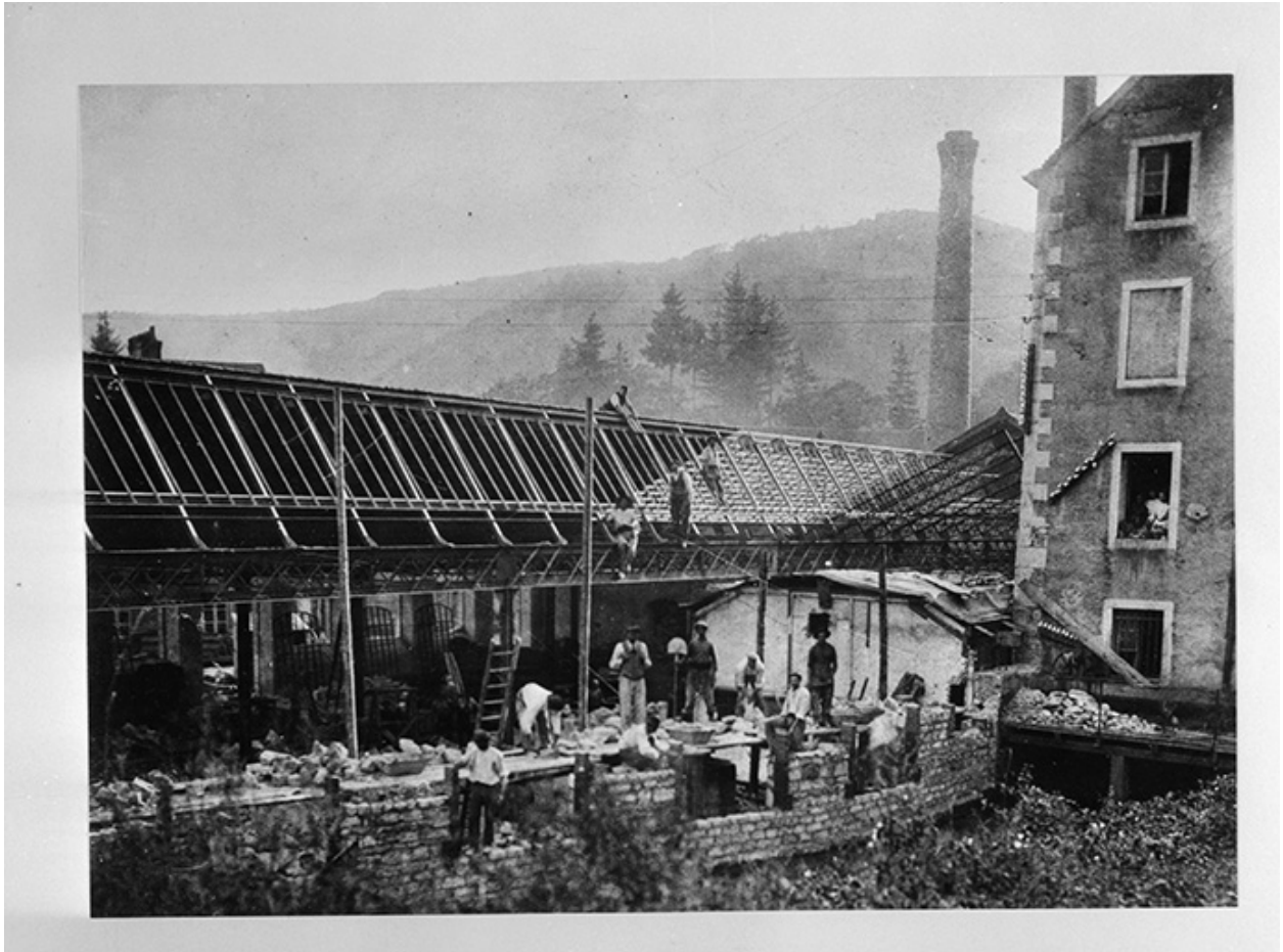
Construction du nouvel atelier de clouterie, fotogr., s.n., s.d. [1904 ?].
