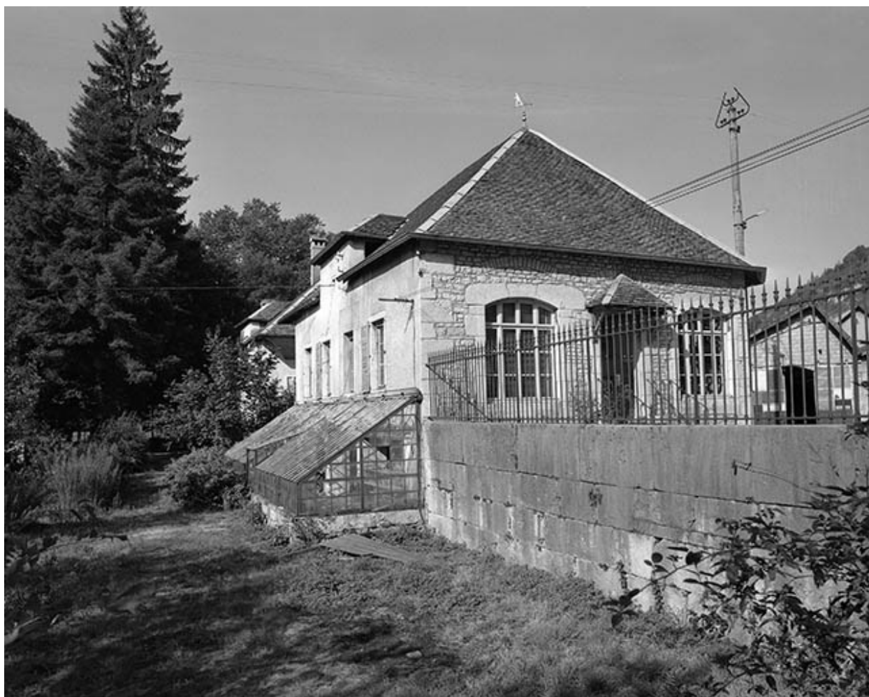
Vue de trois quarts arrière du bâtiment abritant les bureaux, logements, remises et écuries (1980).
