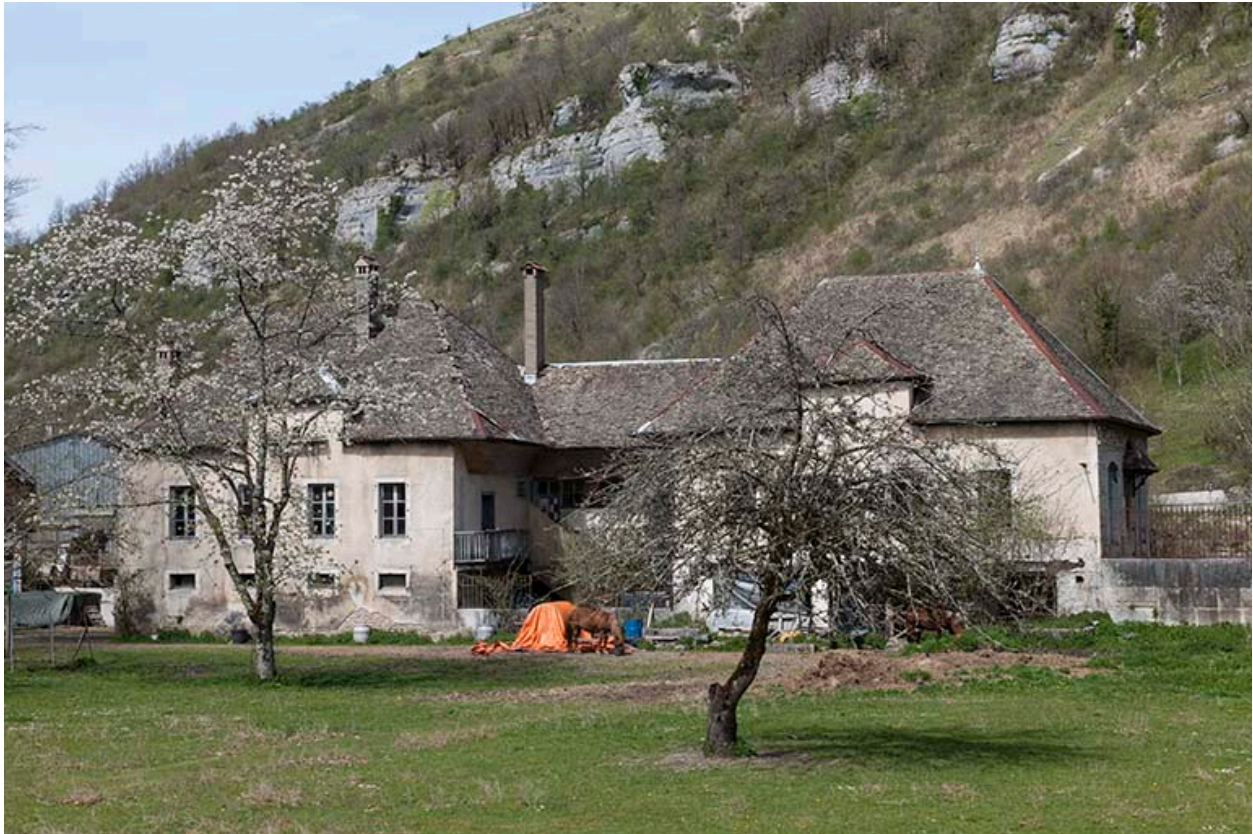
Façade sud du bâtiment abritant les bureaux, logements, écuries et remises.
