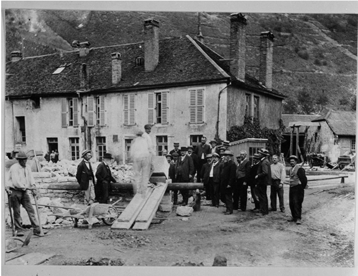
Reconstruction des ateliers. Pose de la première pierre, fotogr., s.n., s.d. [1904 ?].
