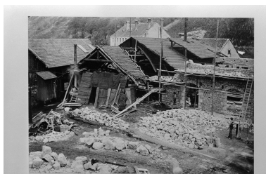
Atelier de "décaperie" en cours de construction, photogr., s.n., s.d. [1904 ?].
