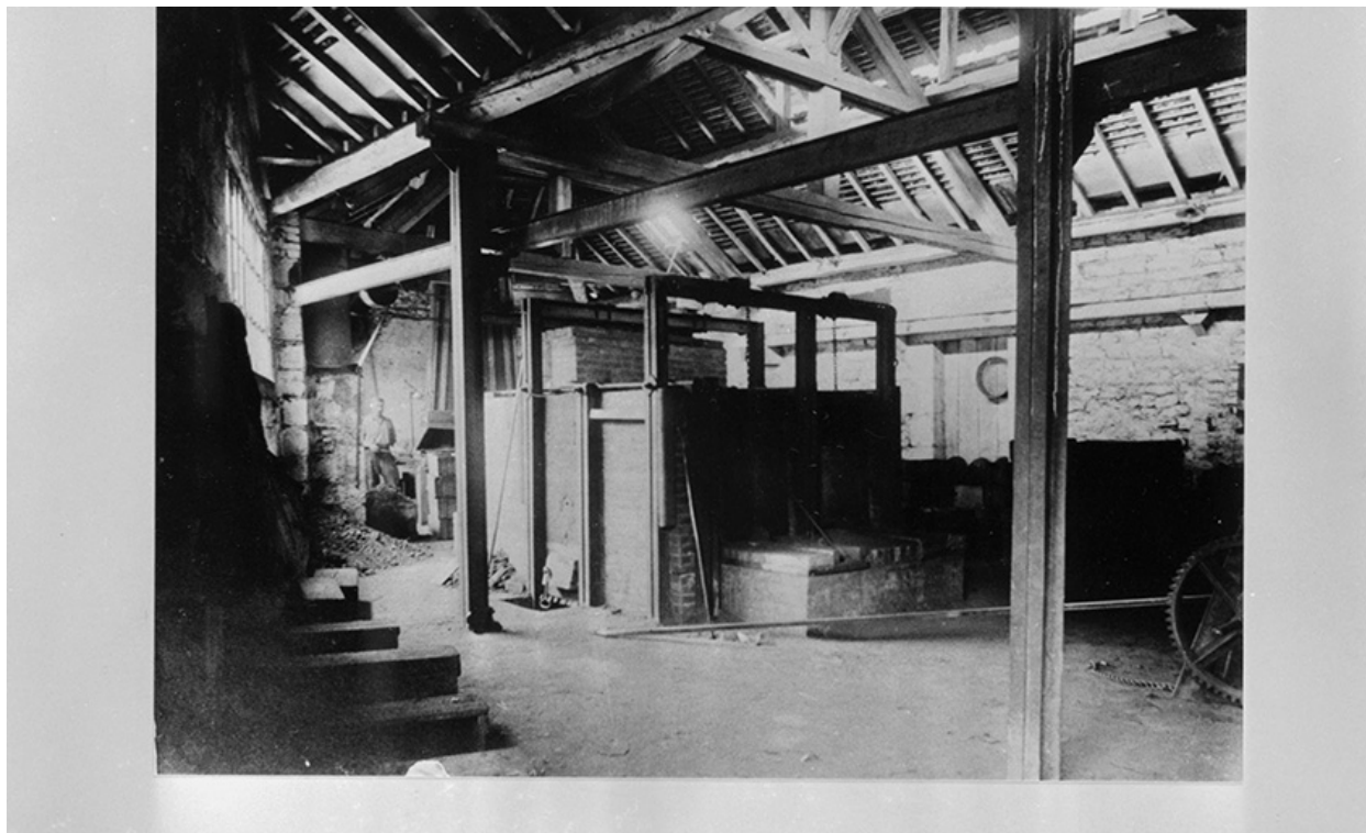
Atelier du four à recuire, fotogr., s.n., s.d. [vers 1890-1900].
