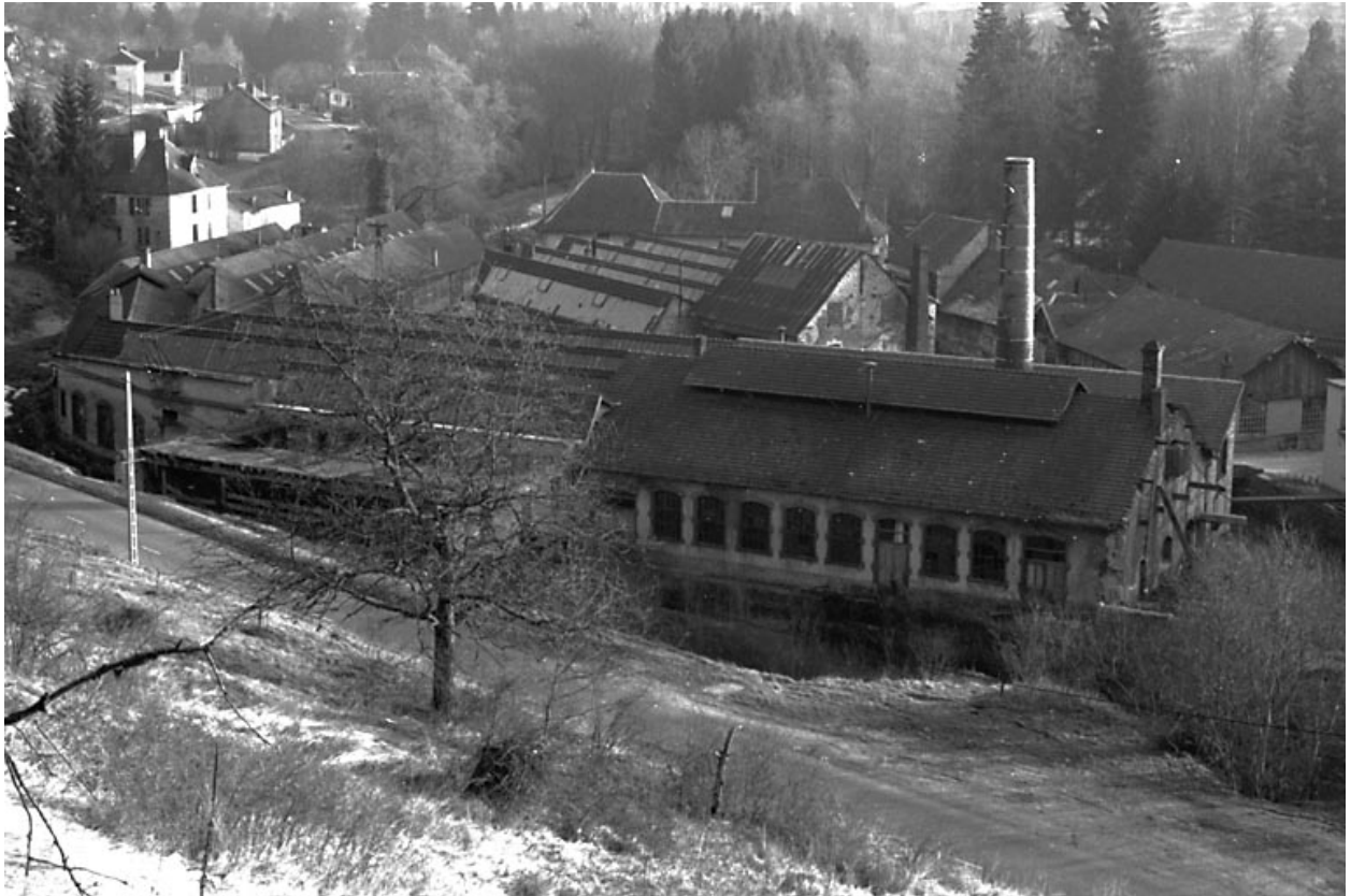
Vue générale depuis le nord en 1989.
