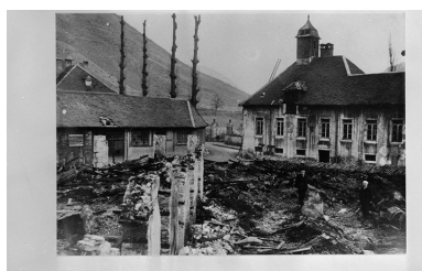
Etat des ateliers après l'incendie de 1903, photogr., s.n., s.d. [1904 ?].
