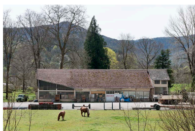
Atelier de mécanique. Phot. Jérôme Mongreville IVR43_20152501186NUC4A
