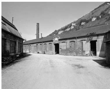
Vue depuis la cour de l'usine en 1980. Phot. Yves Sancey IVR43_19802501418X
