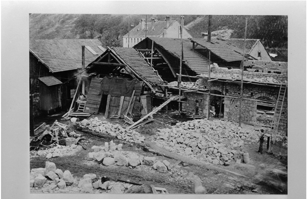
Atelier de "décaperie" en cours de construction, fotogr., s.n., s.d. [1904 ?].
