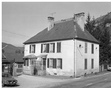
Ancienne conciergerie, en 1980. Phot. Yves Sancey IVR43_19802501416X
