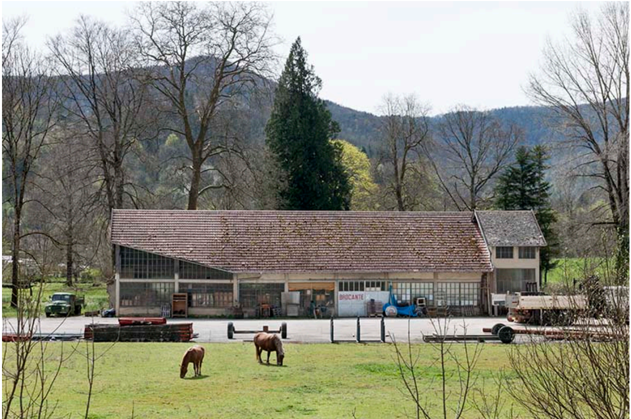
Atelier de mécanique.
