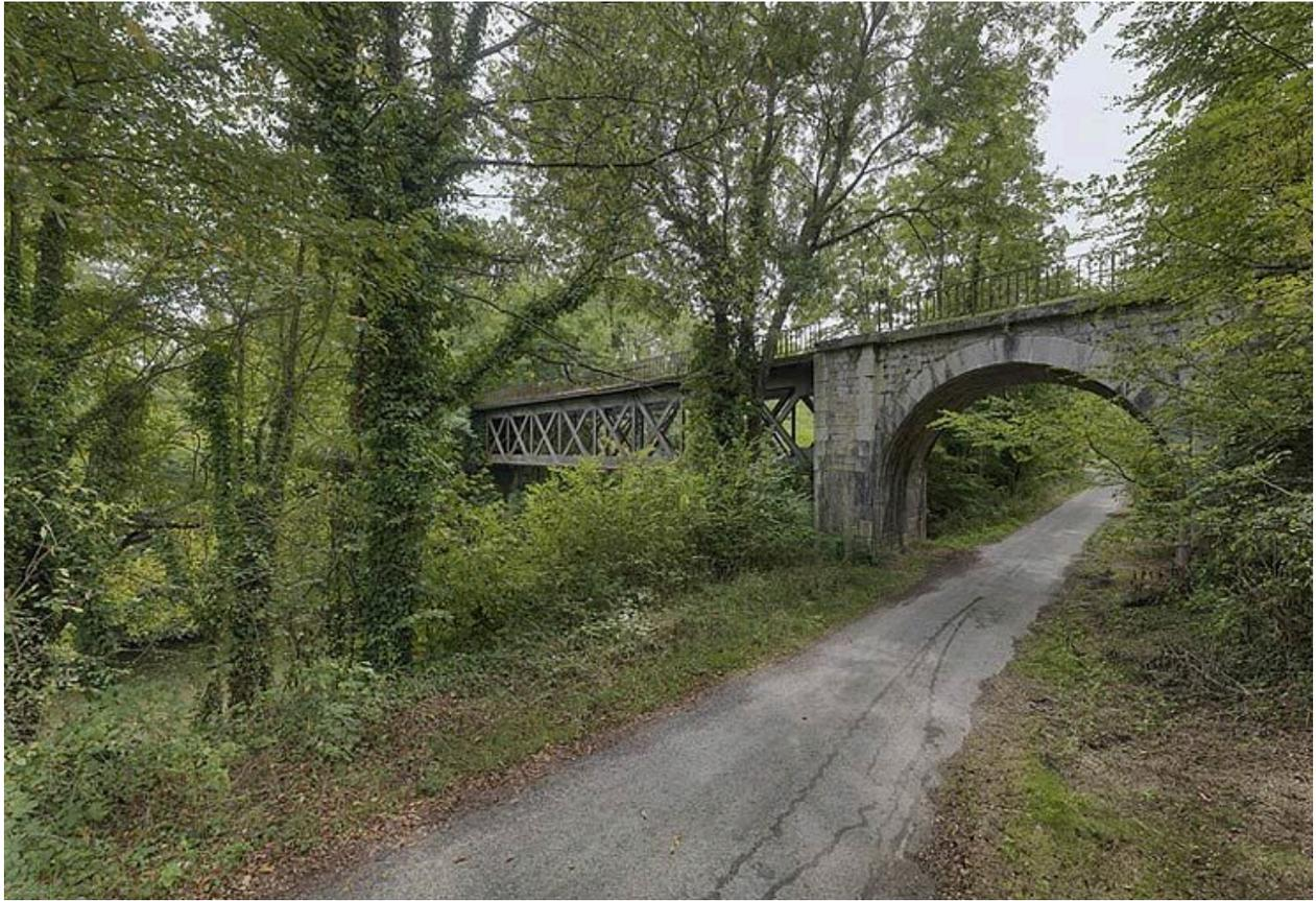
A Montchanin, le pont ferroviaire, avec une partie en maçonnerie enjambant le chemin de halage et une partie en métal enjambant le canal.
