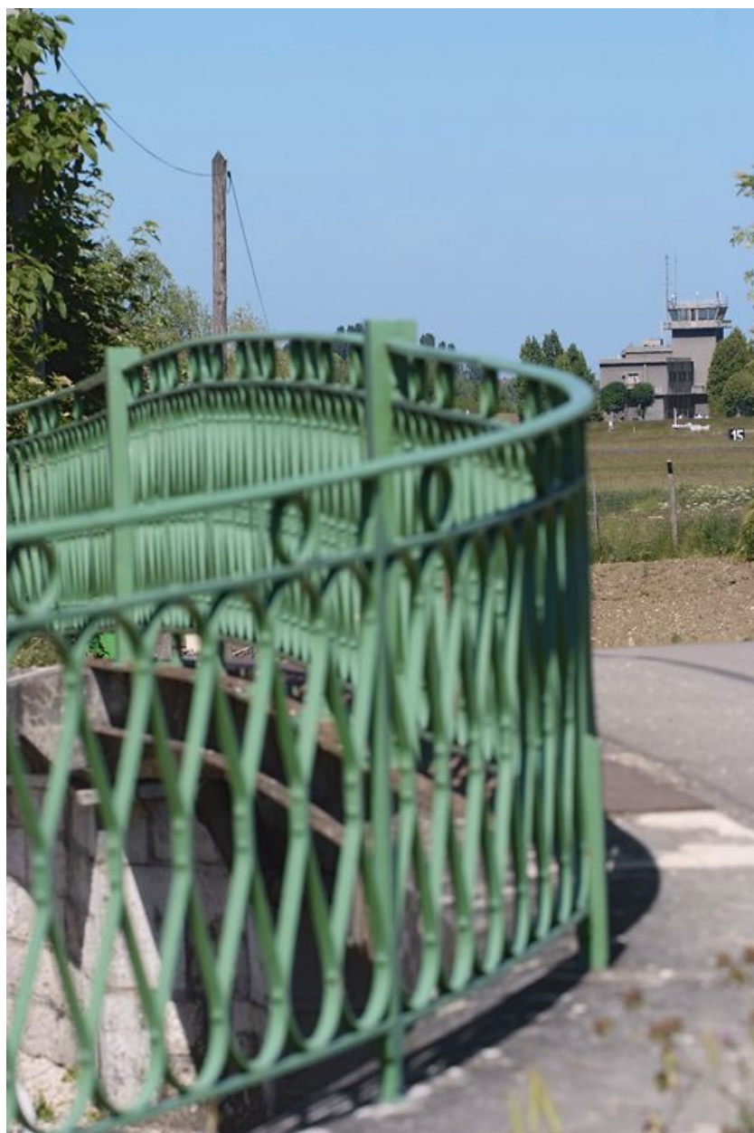
Détail du garde-corps en ferronnerie.
