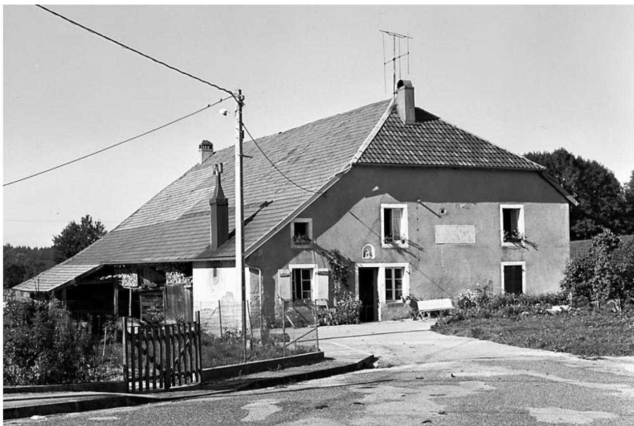
Ferme située rue du Bois Brûlé : vue d'ensemble.
