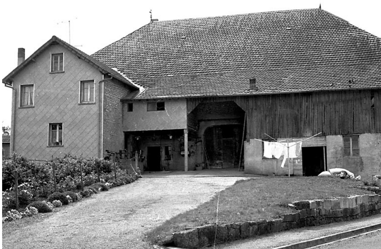
Ferme située route de Villeneuve : façade postérieure.
