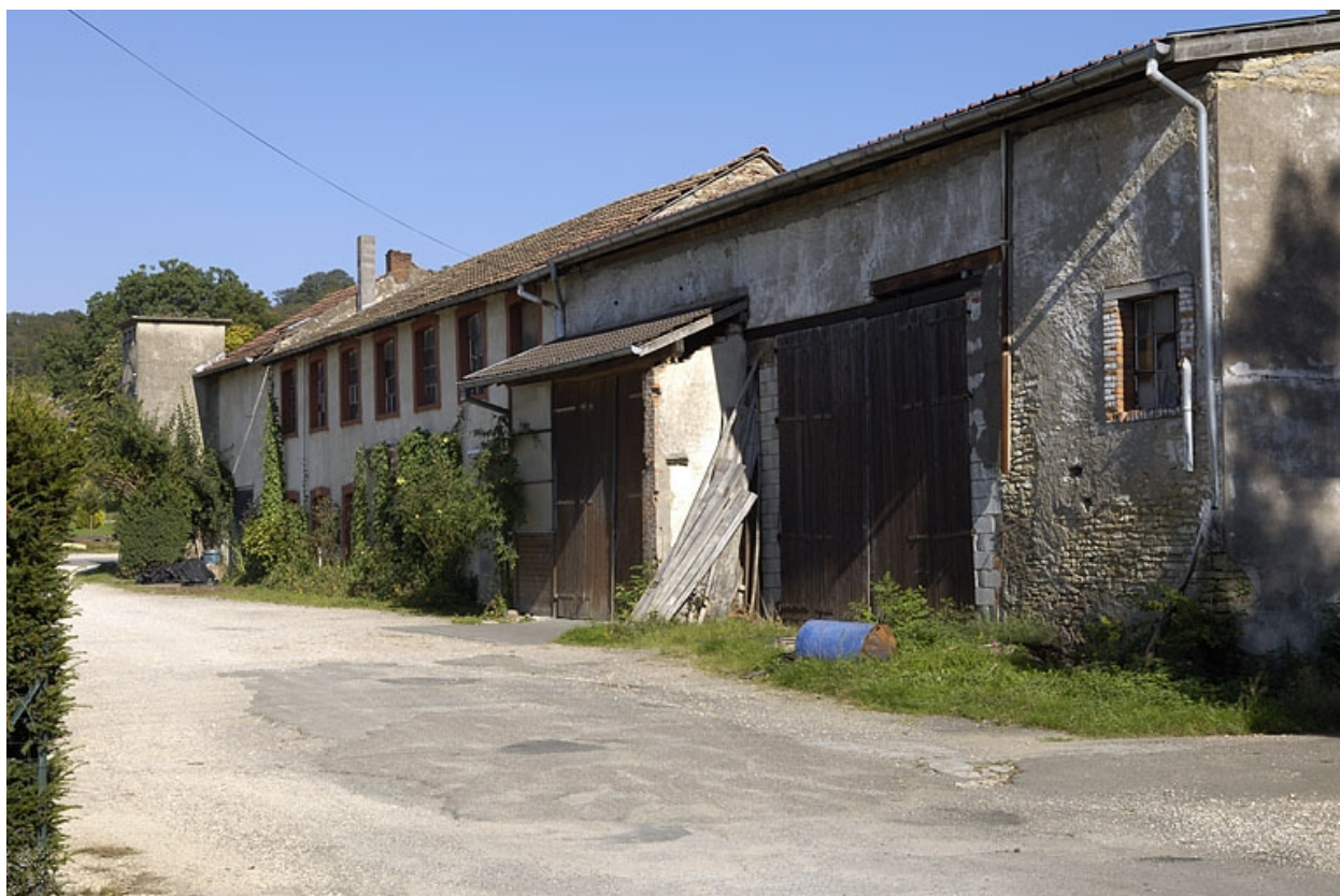
Atelier de boissellerie vu depuis la rue.
