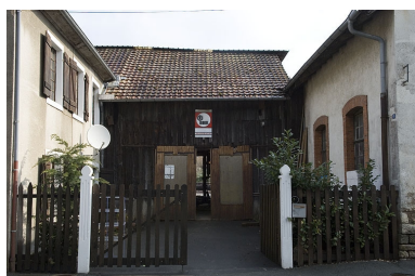
Façade antérieure de l'atelier de scierie. Phot. Jérôme Mongreville IVR43_20067000129NUCA
