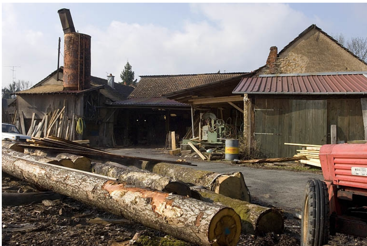
Façade postérieure de l'atelier de scierie.
