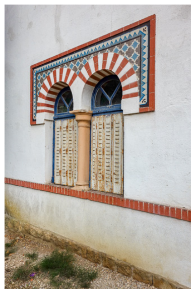
Élévation du pavillon du gardien, baies jumelées du rez-de-chaussée. Phot. Fabien Dufoulon IVR26_20192100103NUC2A
