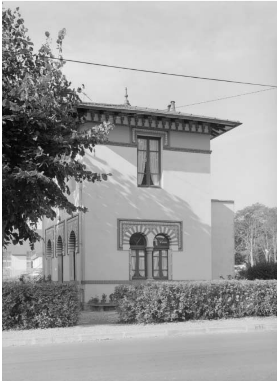
Élévation du pavillon du gardien, vue depuis l'est.
