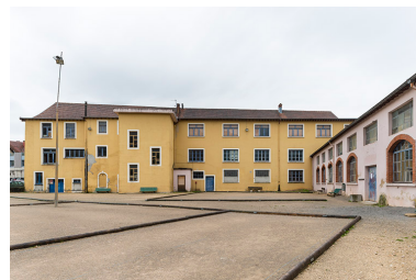
Façade postérieure de l'atelier principal. Phot. Jérôme Mongreville IVR43_20162501576NUC4A
