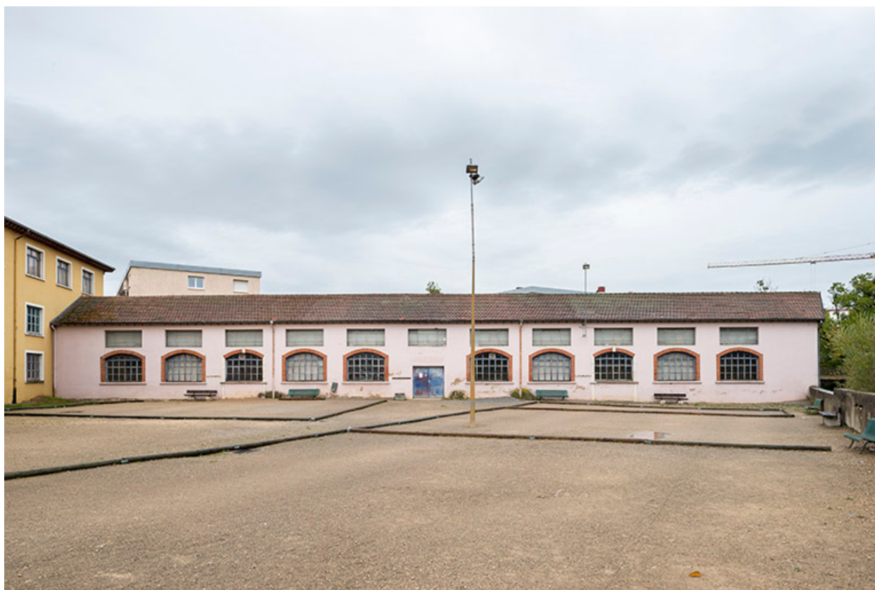
Bâtiment perpendiculaire à l'atelier principal. Façade sud.
