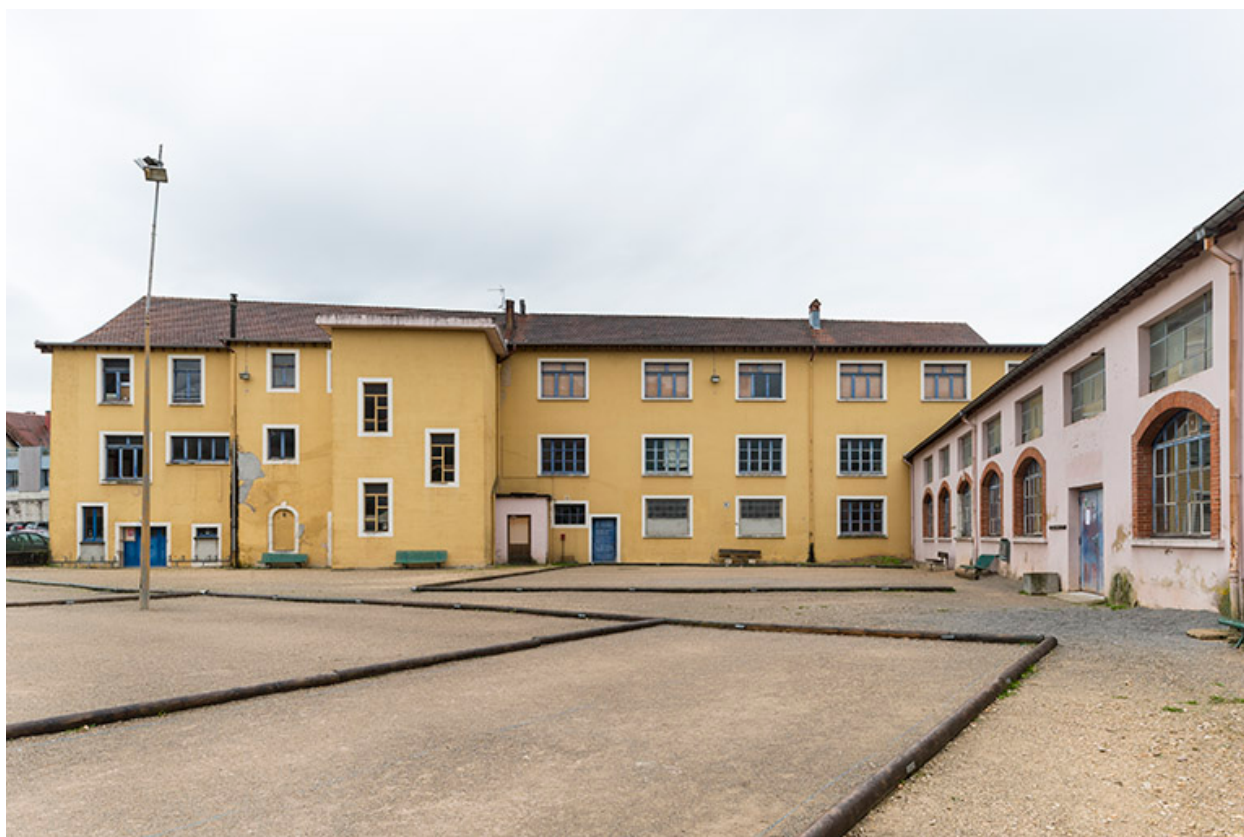
Façade postérieure de l'atelier principal.
