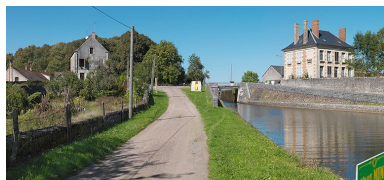
Vue d'ensemble : à gauche la maison éclusière (01L) et à droite la maison des ingénieurs.
