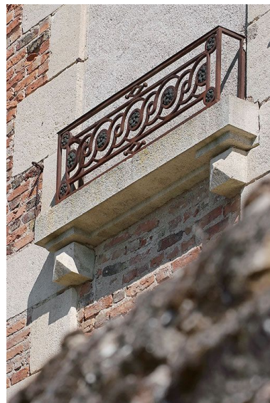
Détail du garde-corps.
