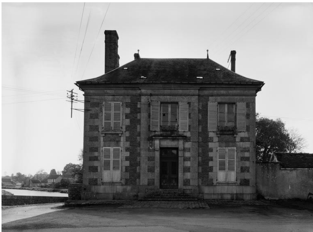
Vue de la façade principale (en 1975).
