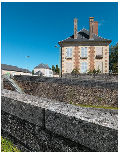
Façade latérale sud.
