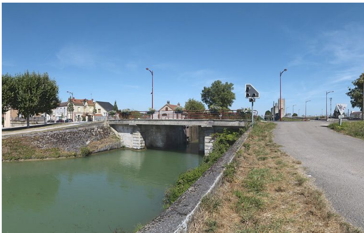
Pont vu d'aval.
