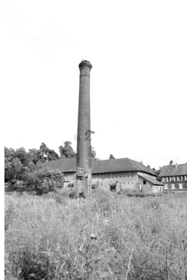
Etat de l'usine en 1980.SRI. Enquête régionale sur les bâtiments industriels (1979-1981).
