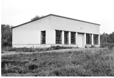
Magasin industriel (affectation actuelle). Phot. Yves Sancey IVR43_20009000750X
