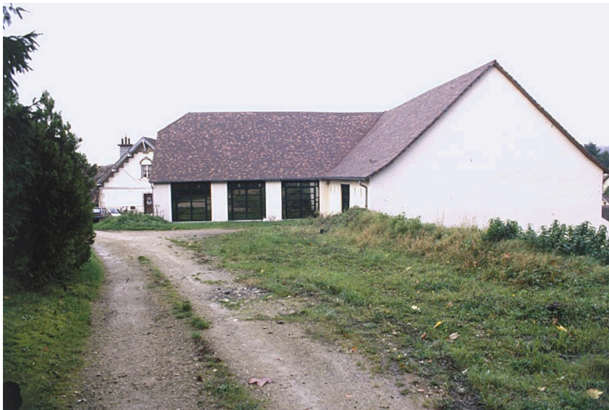
Ancienne halle à charbon depuis l'est.
