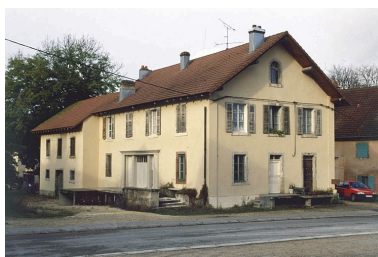
Logement à l'ouest. Phot. Yves Sancey IVR43_20009000766ZA
