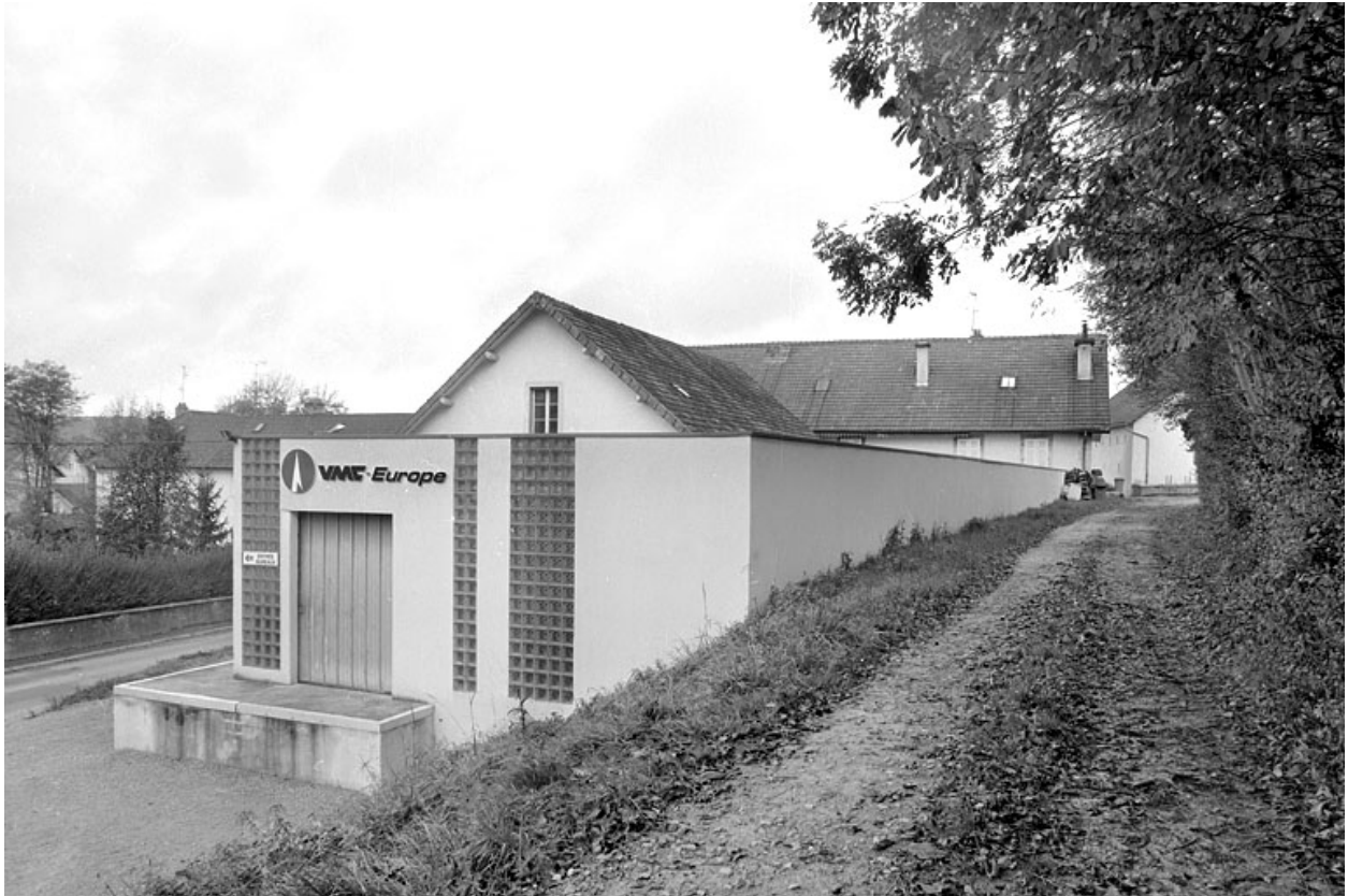
Extension sud du magasin industriel (ancienne halle à charbon).
