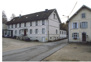
Bureaux et logements. Phot. Yves Sancey IVR43_20009000754ZA
