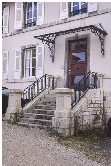
Perron du bâtiment des bureaux. Phot. Yves Sancey IVR43_20009000756ZA
