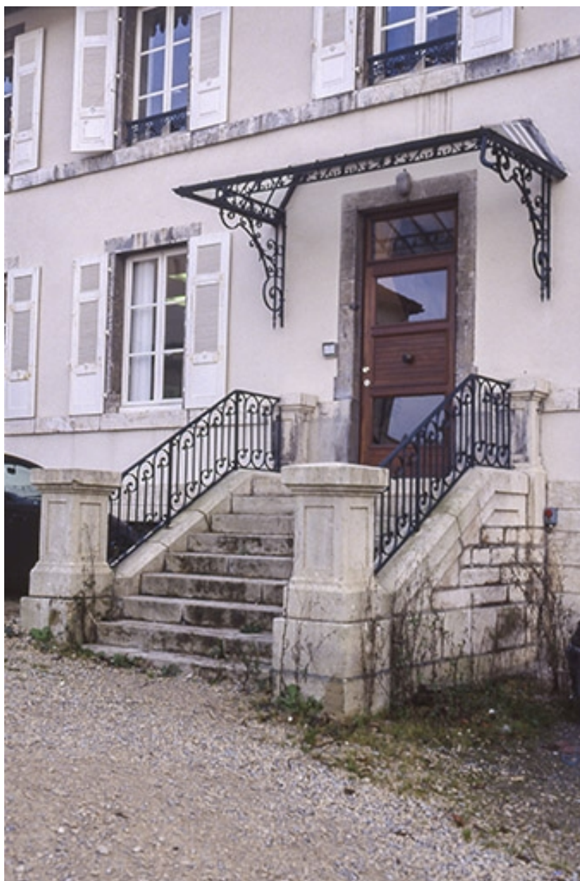
Perron du bâtiment des bureaux.
