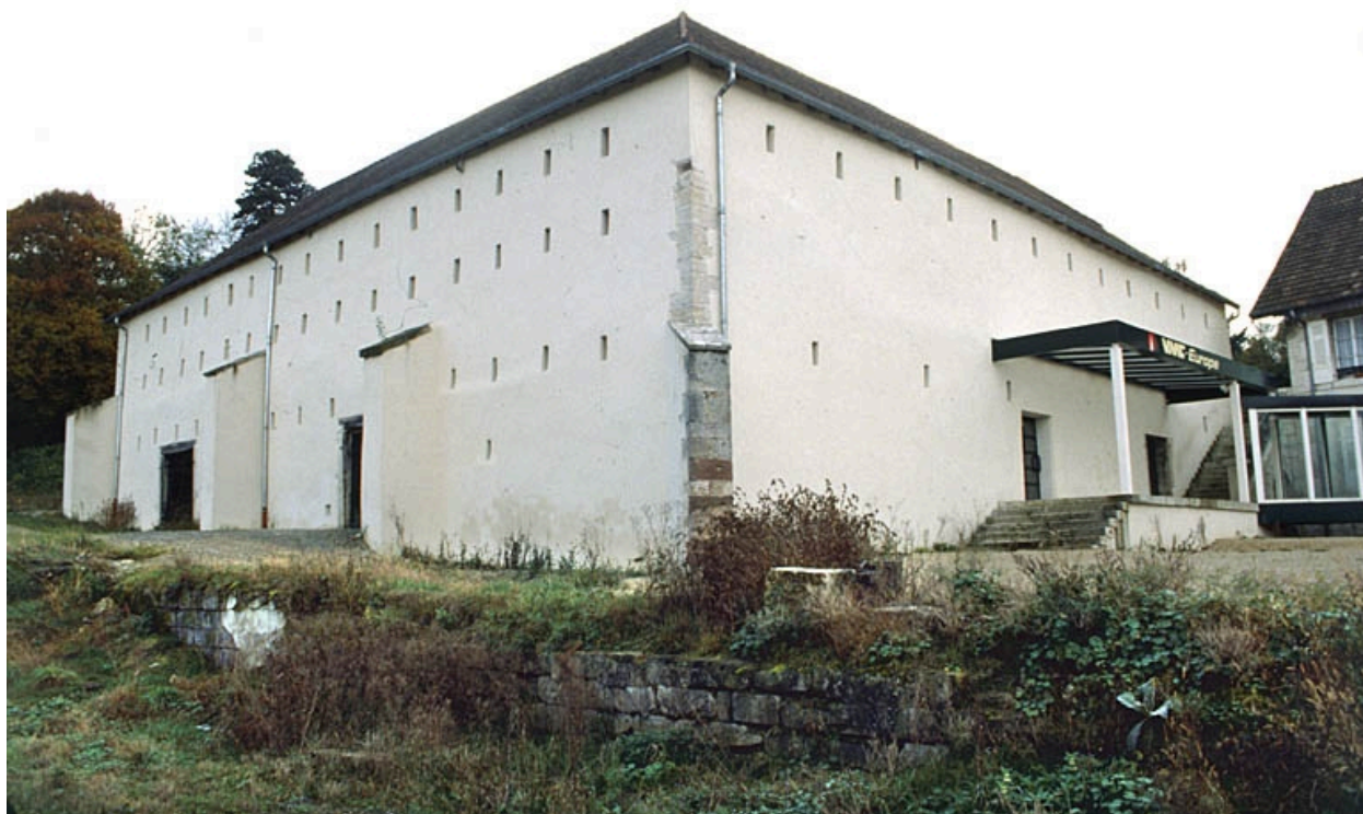
Ancienne halle à charbon depuis le nord-ouest.
