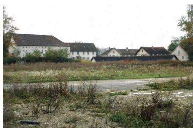
Vue d'ensemble depuis le nord. L'espace au premier plan était occupé par les bâtiments de la forge. Phot. Yves Sancey IVR43_20009000747ZA
