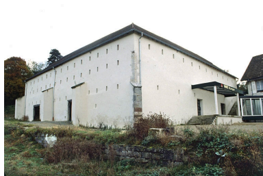
Ancienne halle à charbon depuis le nord-ouest. Phot. Yves Sancey IVR43_20009000758ZA
