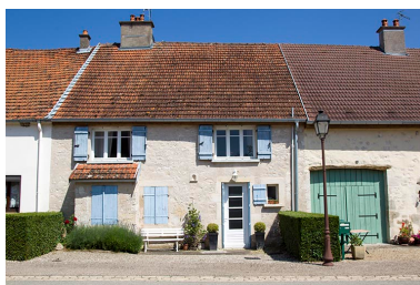
Maison au 43 Grande Rue. Phot. Sonia Dourlot IVR43_20157000382NUC2A
