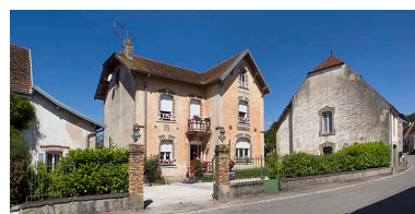
Maison au 32 Grande Rue. Phot. Sonia Dourlot IVR43_20157000312NUC2A
