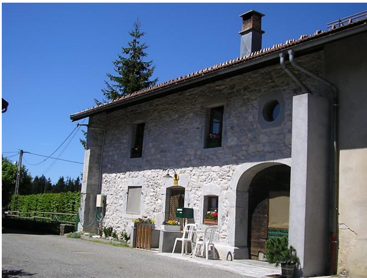
Façade antérieure vue de trois quarts.
