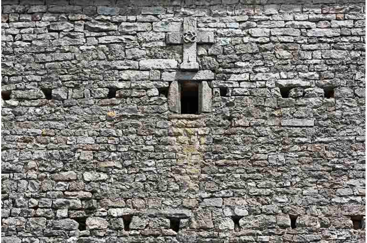
Croix sous la demi-croupe du mur pignon 16 rue des Vosges.
