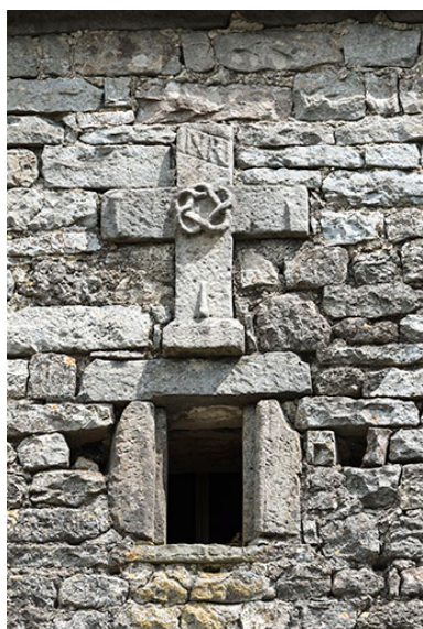
Détail de la croix sous la demi-croupe du mur pignon 16 rue des Vosges. Phot. Sonia Dourlot IVR43_20167001250NUC4A
