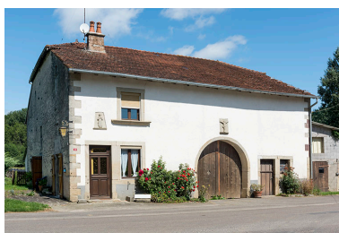
Ferme au 10 rue du Moulin : façade antérieure ornée de deux sculptures religieuses. Phot. Sonia Dourlot IVR43_20167001258NUC4A
