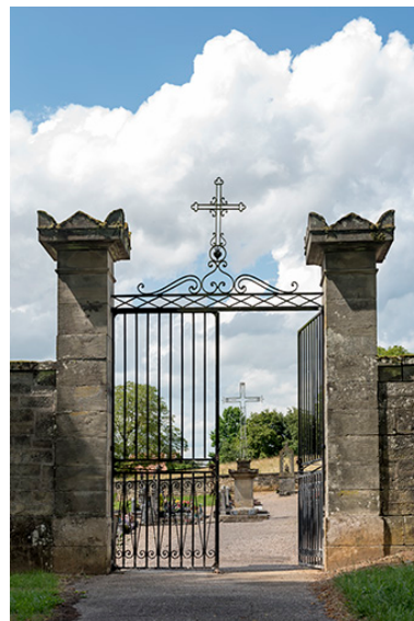
Porte flamande de l'entrée du cimetière. Phot. Sonia Dourlot IVR43_20177000070NUC4A
