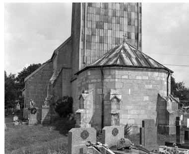
Porche : côté ouest. Phot. Dominique Humbert IVR43_19762500211X
