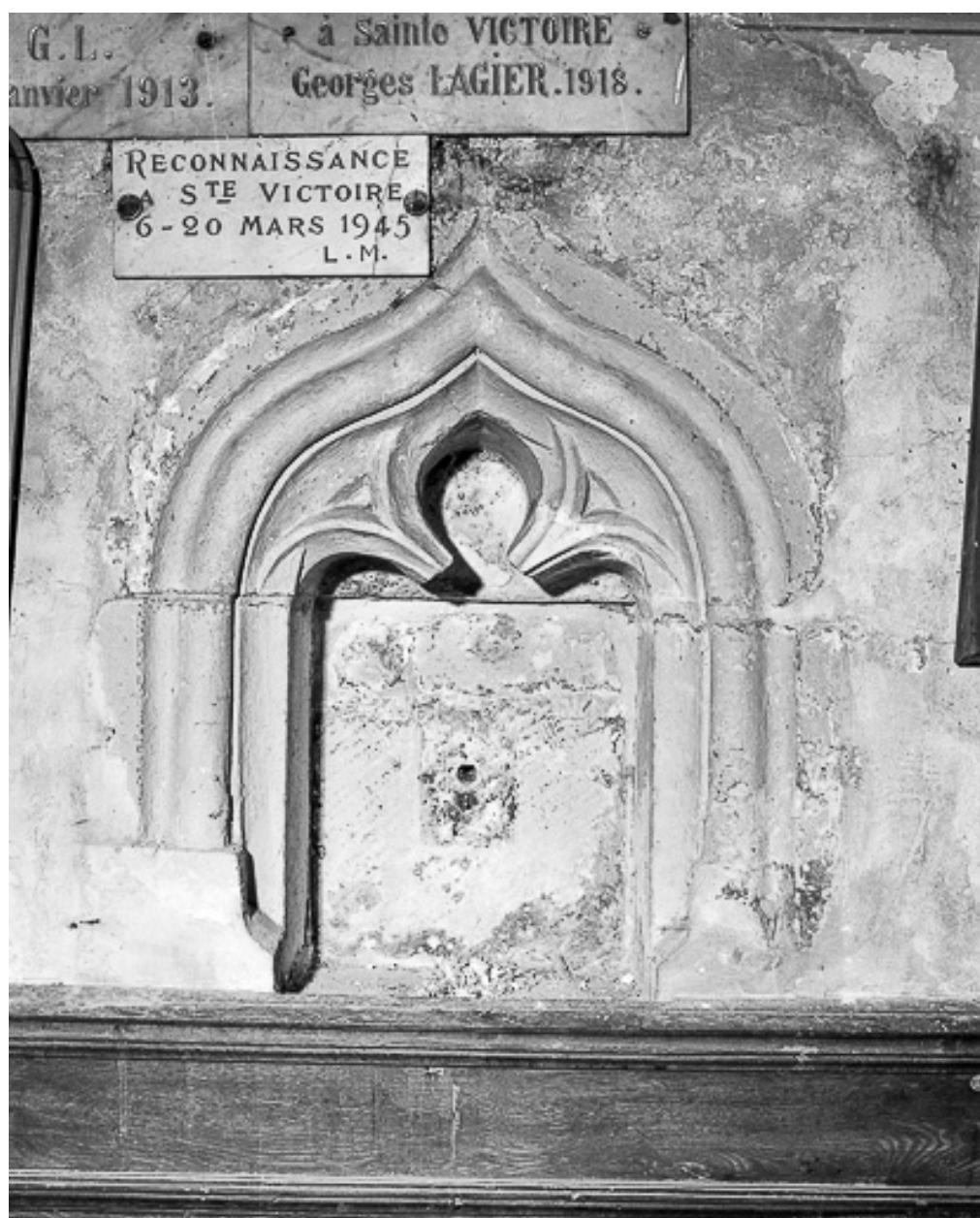
Lavabo de la chapelle latérale droite.
