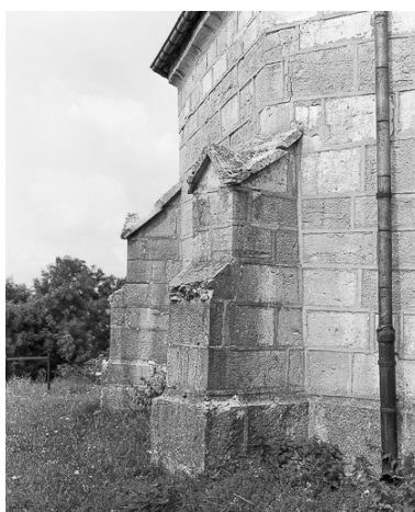
Porche : contrefort. Phot. Dominique Humbert IVR43_19762500213X
