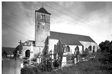
Façade latérale droite. Phot. Dominique Humbert IVR43_19762500209V
