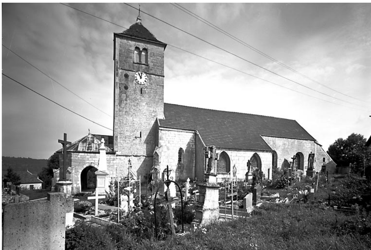
Façade latérale droite.
