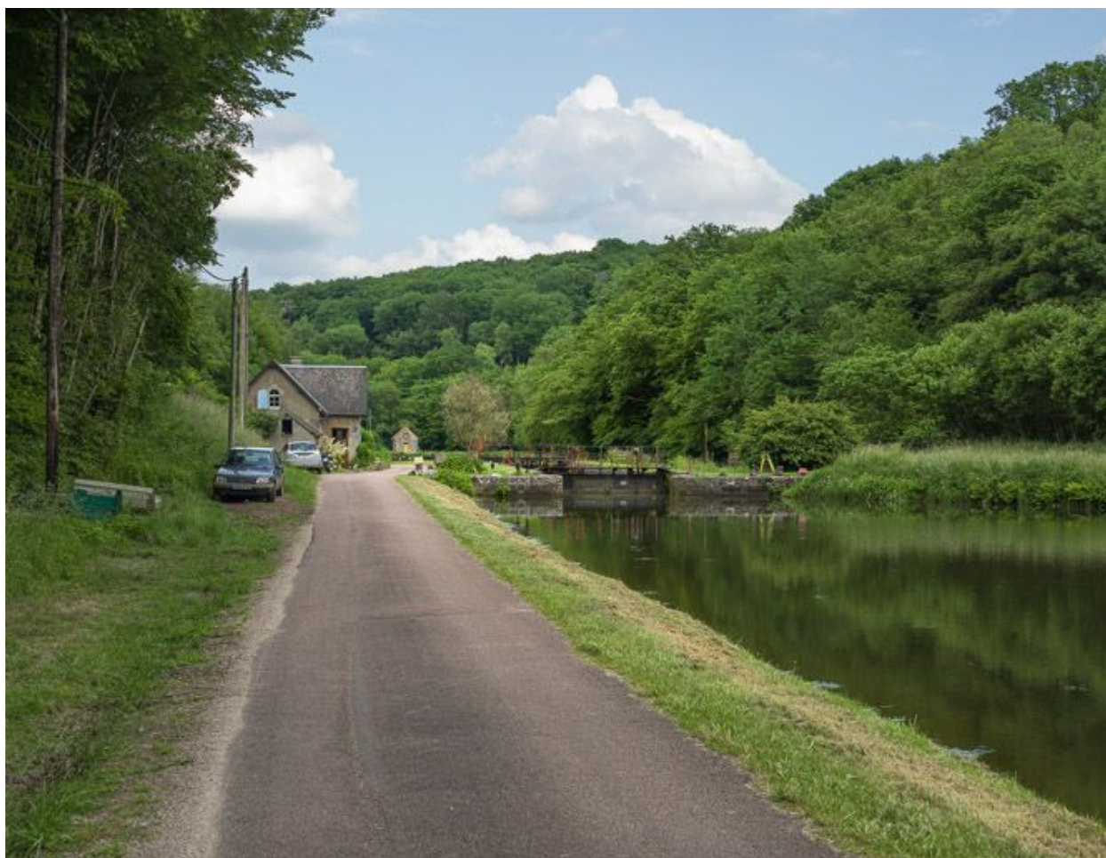
Le site d'écluse vu d'amont.
