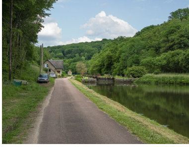
Le site d'écluse vu d'amont. Phot. Pierre-Marie Barbe-Richaud IVR26_20135800436NUC4AQ
