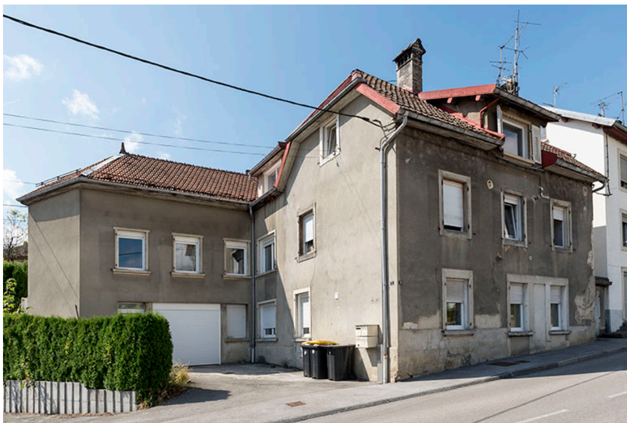
Façades antérieure et latérale gauche.
