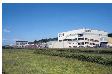
Decize, vue d'ensemble des bâtiments de l'usine de caoutchouc Kléber-Colombes depuis la rive gauche du canal du Nivernais.
