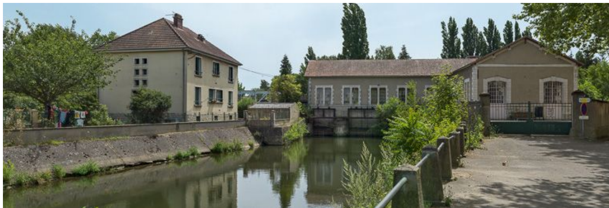
Auxerre, le moulin du Batardeau et le bief de dérivation. A gauche, l'arrière de la maison éclusière.
