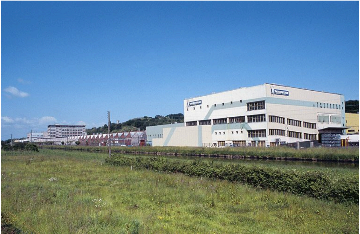
Decize, vue d'ensemble des bâtiments de l'usine de caoutchouc Kléber-Colombes depuis la rive gauche du canal du Nivernais.
