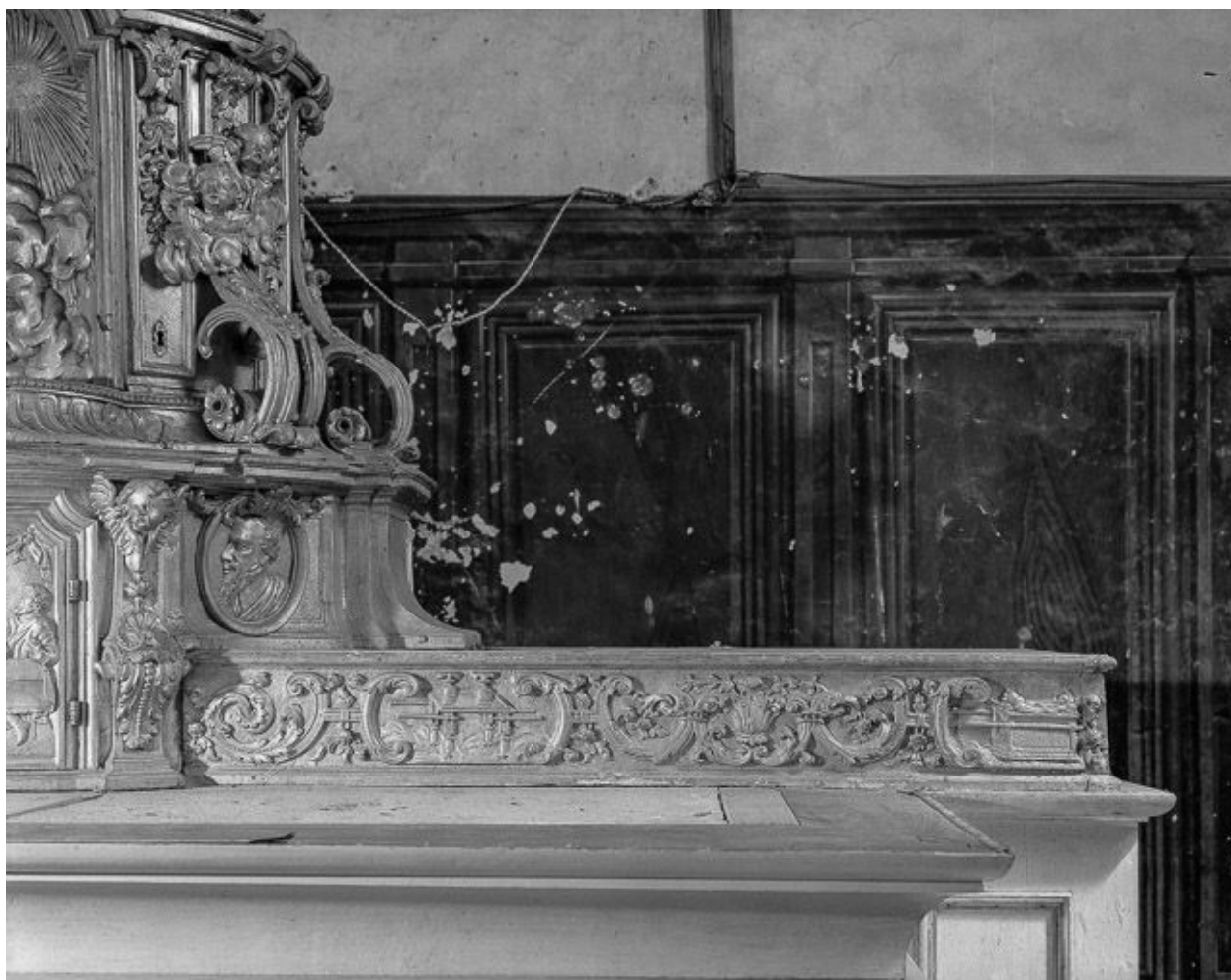
Détail : partie droite du gradin.
