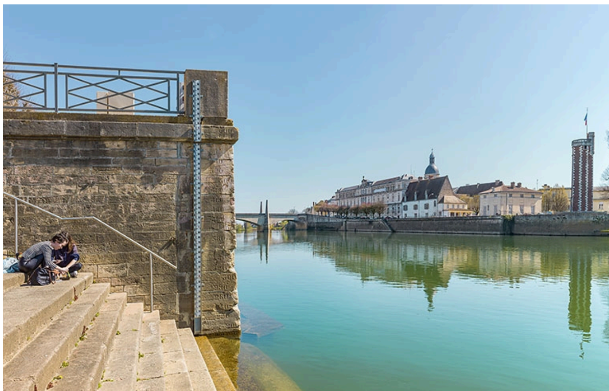
L'échelle de crue historique du port Villiers.
