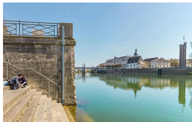
L'échelle de crue historique du port Villiers. Phot. Thierry Kuntz IVR26_20217100092NUC4A
