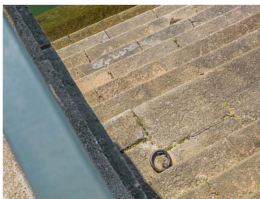
Les marches du port Villiers : détail d'un organeau. Phot. Thierry Kuntz IVR26_20217100097NUC4A
