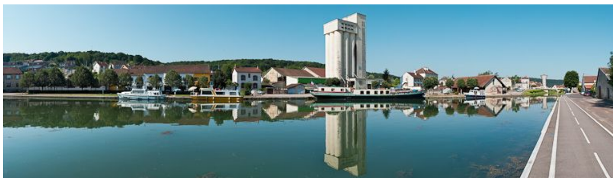
Vue d'ensemble du port de Montbard.
