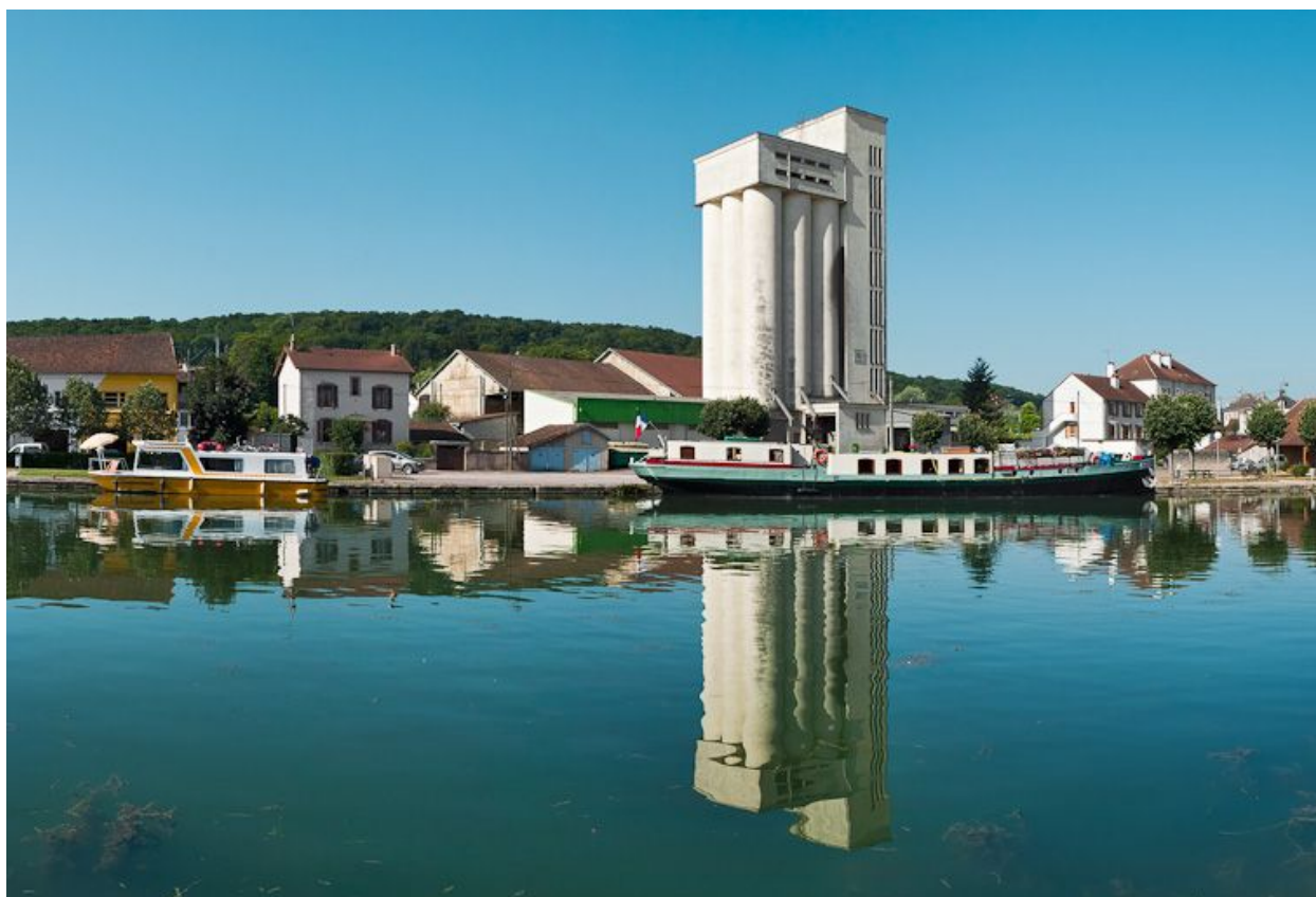
Vue d'ensemble du port.
