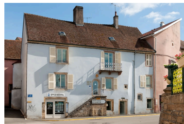
Vue rapprochée. Phot. Jérôme Mongreville IVR43_20102500672NUC4A
