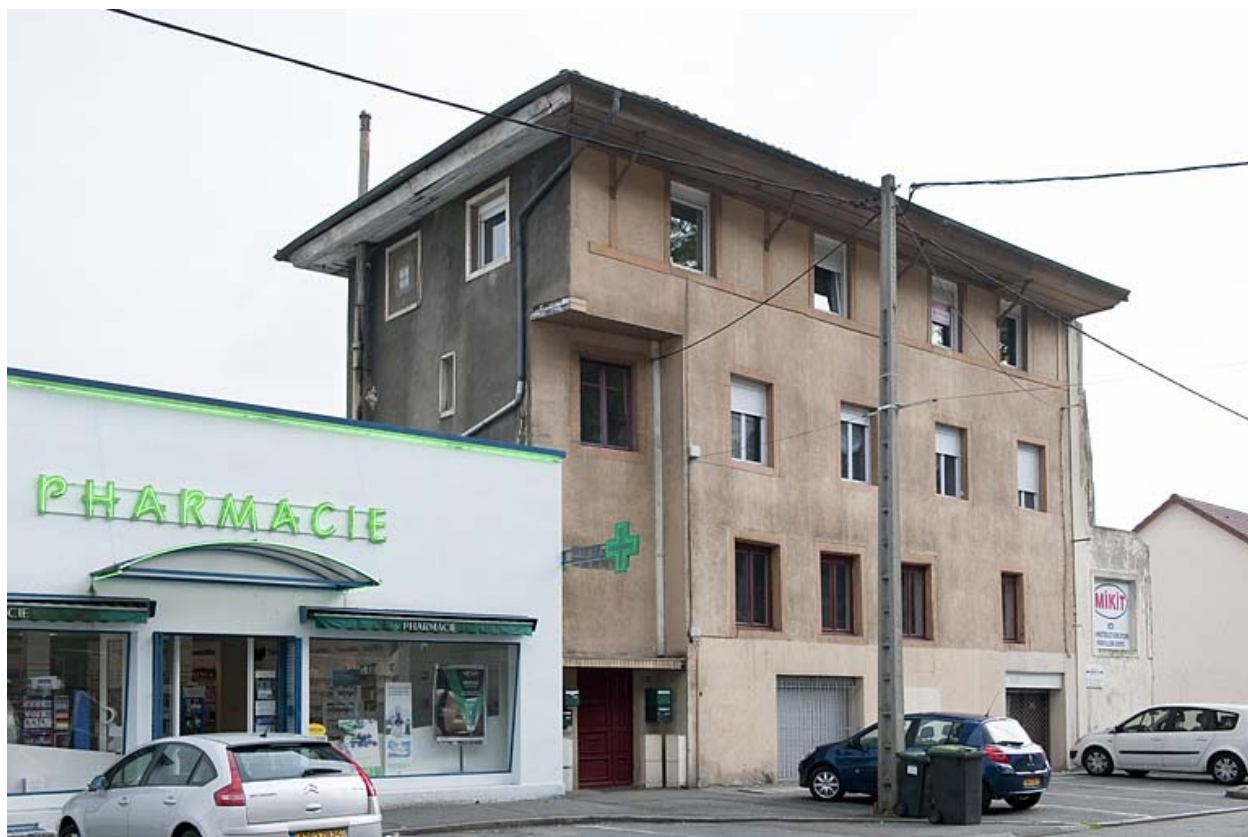
Vestiges de l'atelier depuis la rue.
