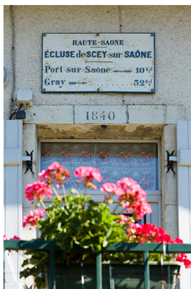
La plaque signalétique sur la maison d'éclusier. Phot. Sonia Dourlot
