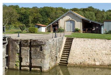
Vue partielle d'un bajoyer de l'écluse, perré et remise en arrière plan. Phot. Sonia Dourlot IVR43_20157000783NUC2A
