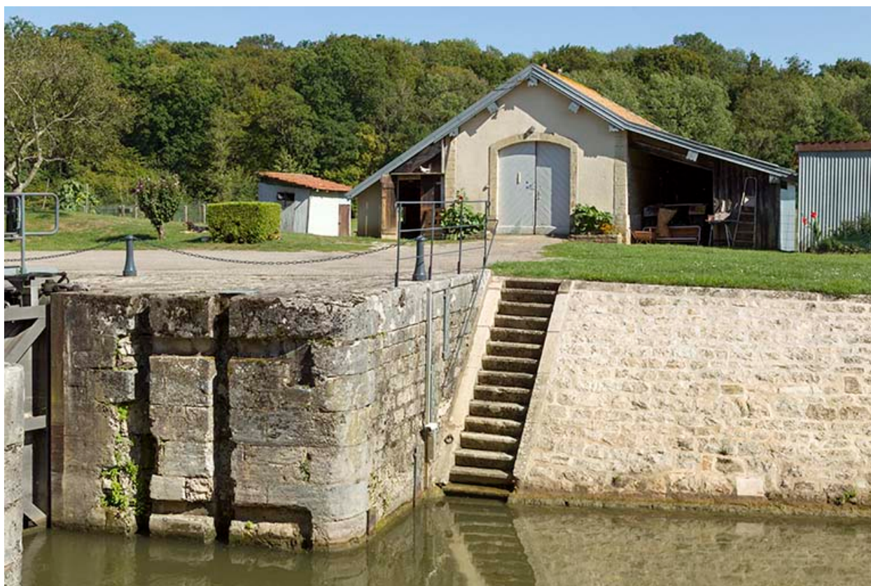
Vue partielle d'un bajoyer de l'écluse, perré et remise en arrière plan.
