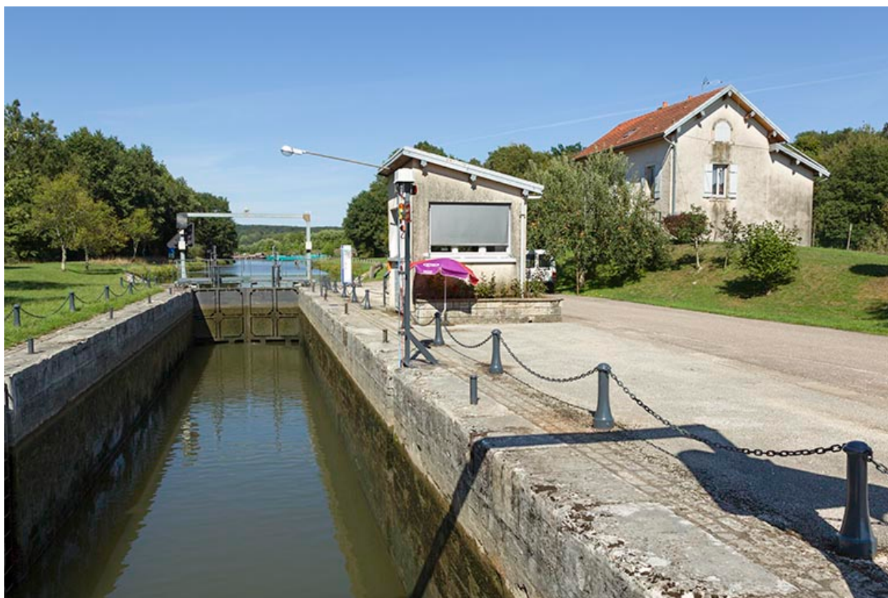
L'écluse à sas.
