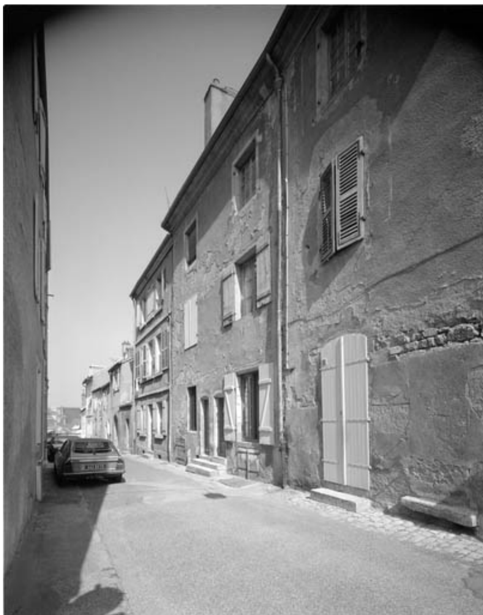
Façade latérale gauche.
