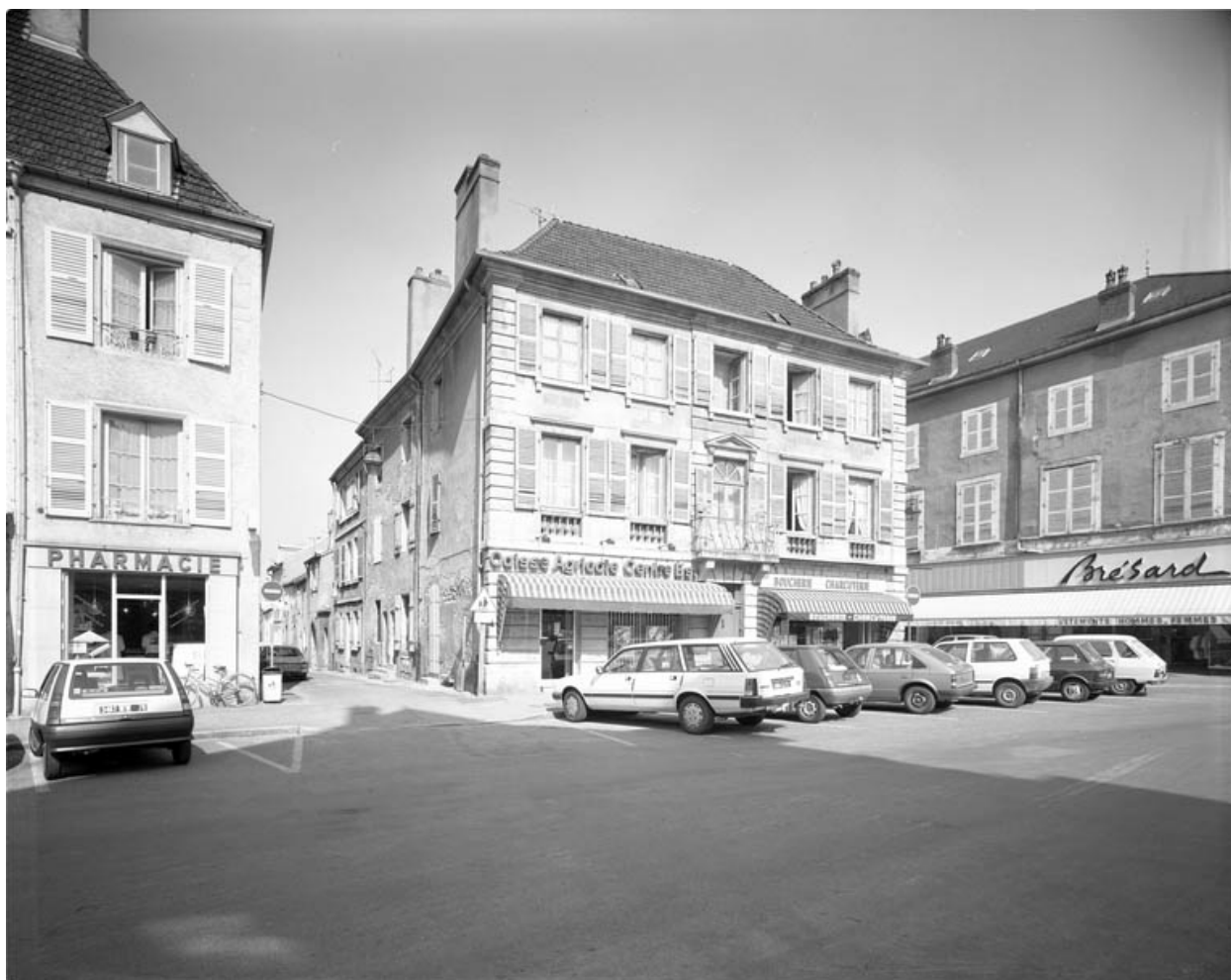
Façade antérieure et latérale gauche.
