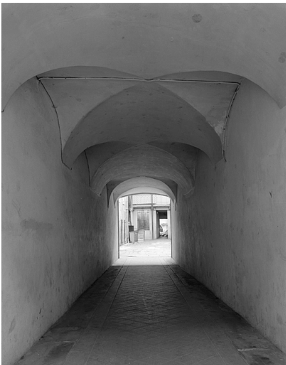
Passage d'entrée donnant accès à la cour.
