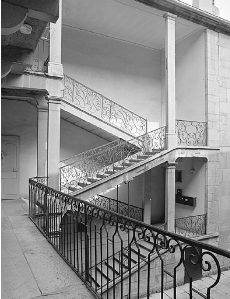
Escalier dans la cour.
