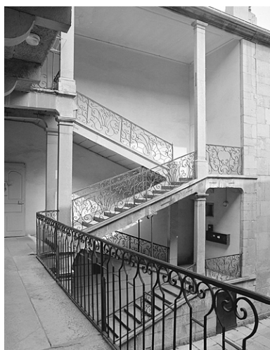
Escalier dans la cour. Phot. Yves Sancey IVR43_19833900306X
