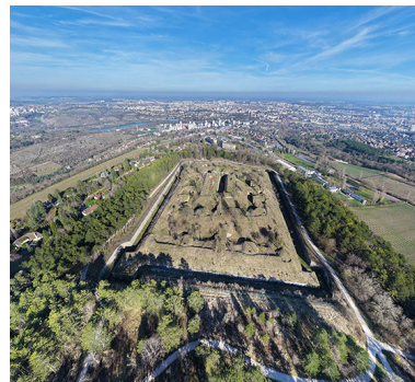
Vue générale du fort. (vue aérienne). Phot. Nicolas Douriaux IVR26_20262100339NUC4A
