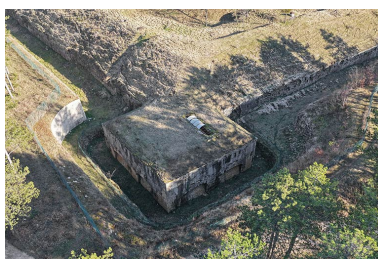
La double caponnière, au saillant 3. (vue aérienne). Phot. Nicolas Douriaux IVR26_20262100392NUC4A
