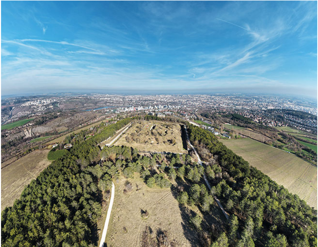
Le fort sur son plateau et surplombant la ville. (vue aérienne).
