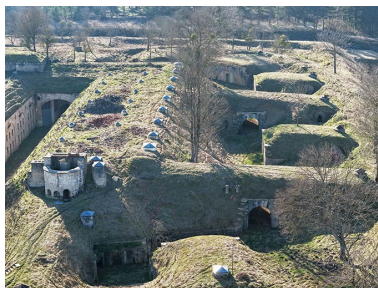
Les plateformes de tir et les traverses-abris (façade nord). (vue aérienne). Phot. Nicolas Douriaux IVR26_20262100388NUC4A
