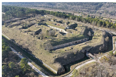
Vue est. (vue aérienne). Phot. Nicolas Douriaux IVR26_20262100375NUC4A
