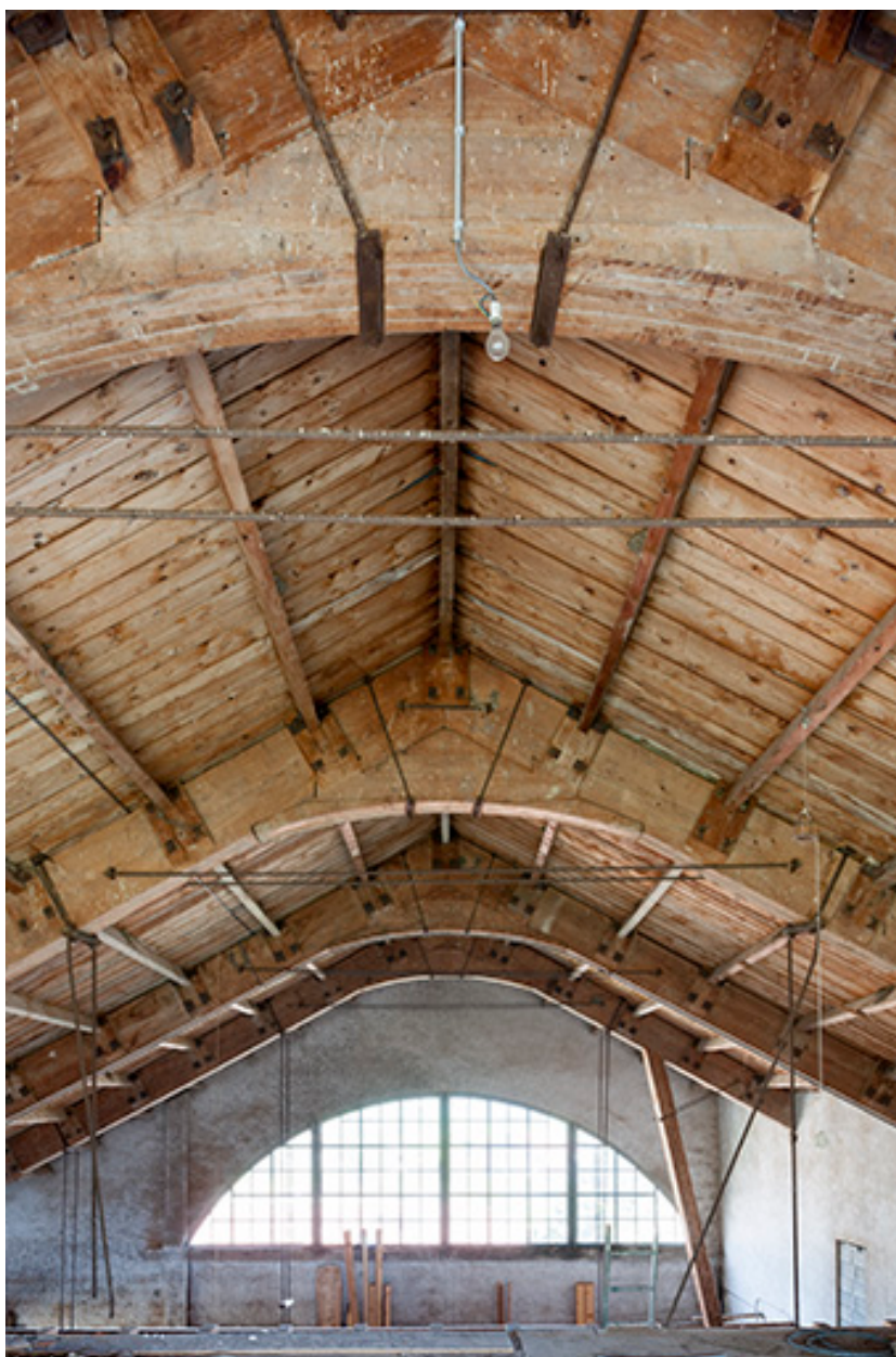
Vue axiale de la charpente, depuis l'ouest.
