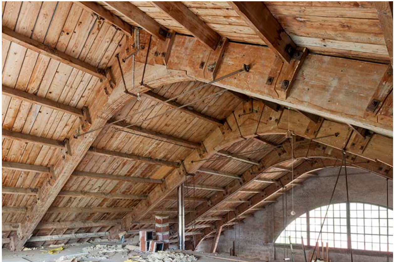
Vue désaxée de la charpente.
