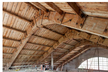
Vue désaxée de la charpente. Phot. Jérôme Mongreville IVR43_20152501895NUC4A
