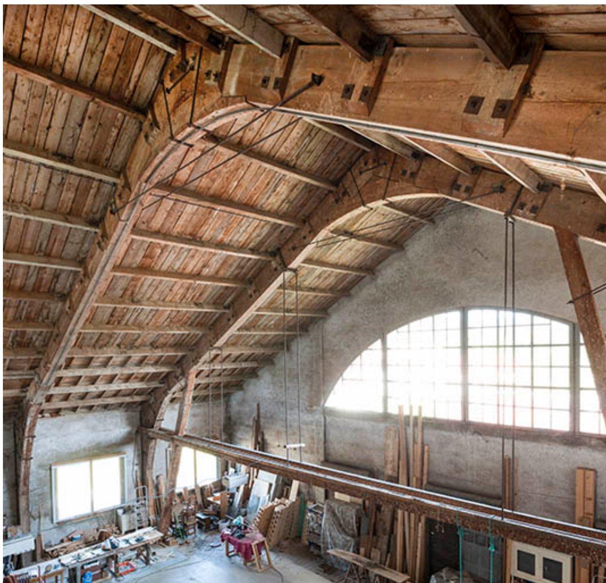
Vue d'ensemble de la charpente.
