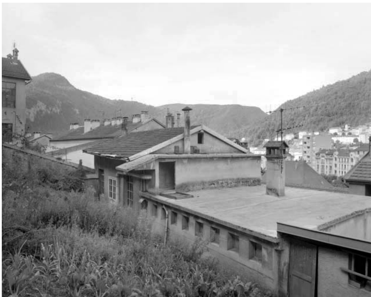
Façade postérieure des ateliers de fabrication.
