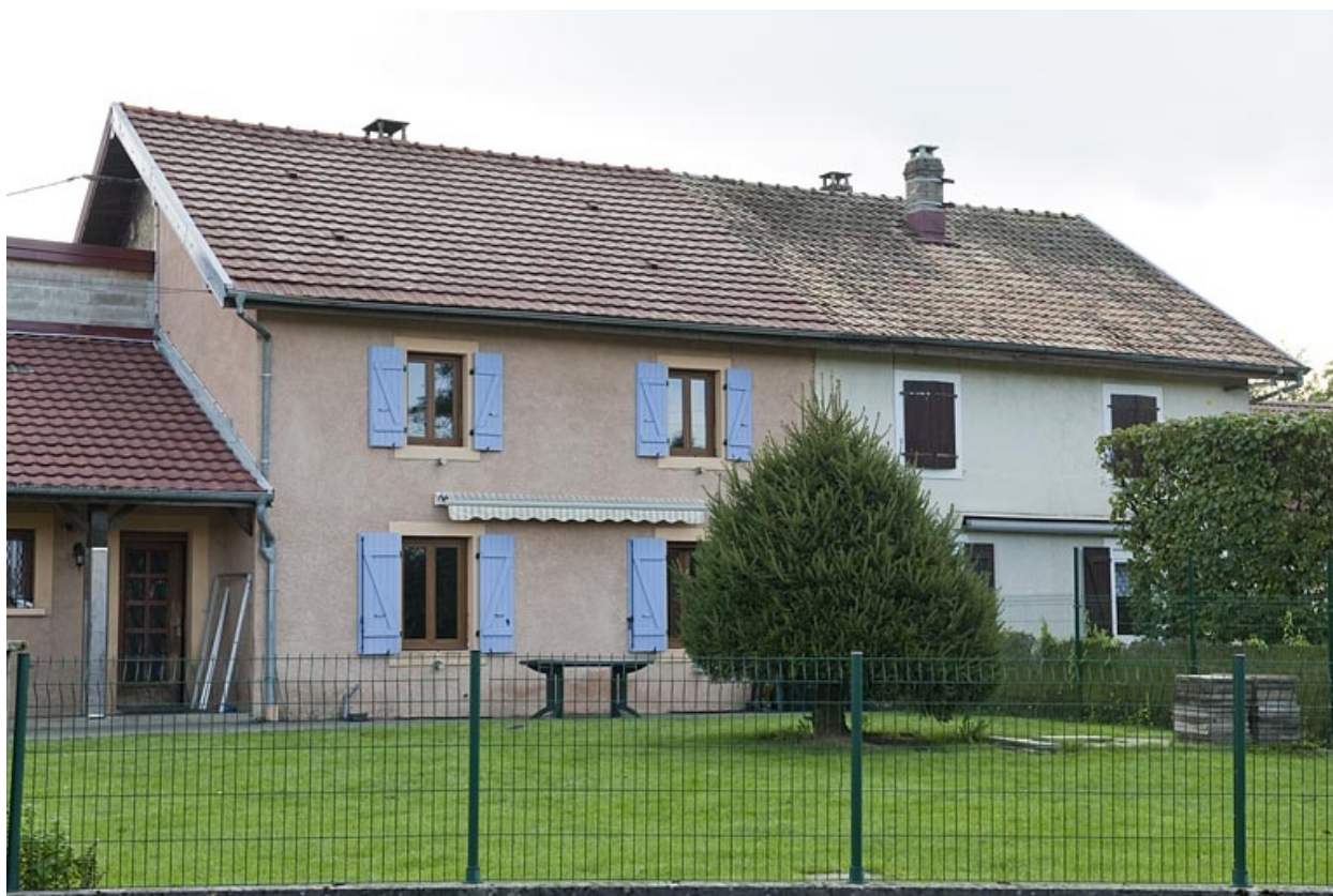
Habitation de 4 logements. Façade ouest.
