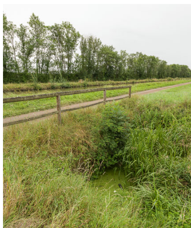
Vue de l'aqueduc.
