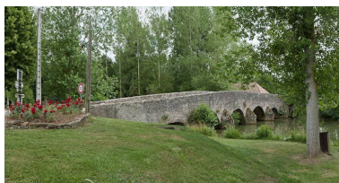
Vue du pont ancien sur l'Ouche prolongeant le pont sur l'écluse 36 du versant Saône. Phot. Pierre-Marie Barbe-Richaud IVR26_20112103511NUC4AQ
