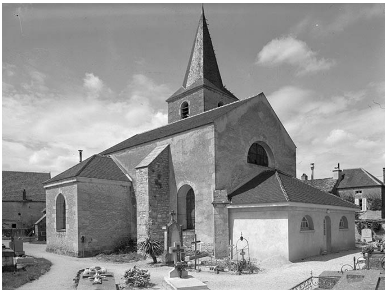
Façade sud et chevet
