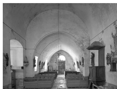
Vue de la nef depuis le chœur Phot. Jean-Luc Duthu IVR26_19748901008V
