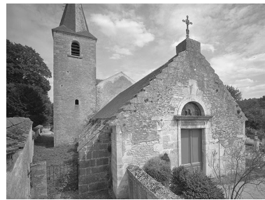
Façade ouest Phot. Jean-Luc Duthu IVR26_19748901005V
