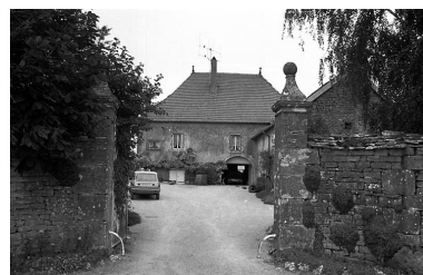
Ferme située route de Bonboillon. Phot. Bernard Lardière IVR43_19797000028Z
