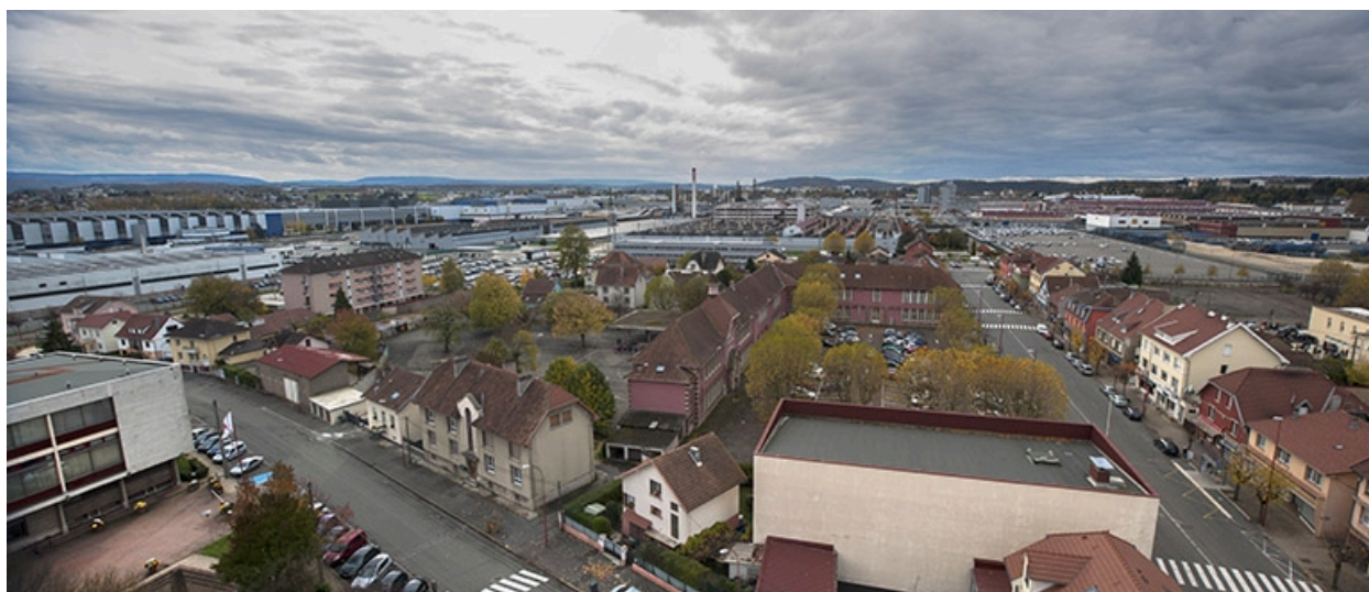
Vue panoramique (depuis l'est) de l'usine d'automobile Peugeot, à Sochaux.
