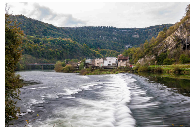
Usine d'outillage Bost Garnache à Laissey. Vue depuis l'extrémité orientale du barrage. Phot. Jérôme Mongreville IVR43_20142501610NUC4A
