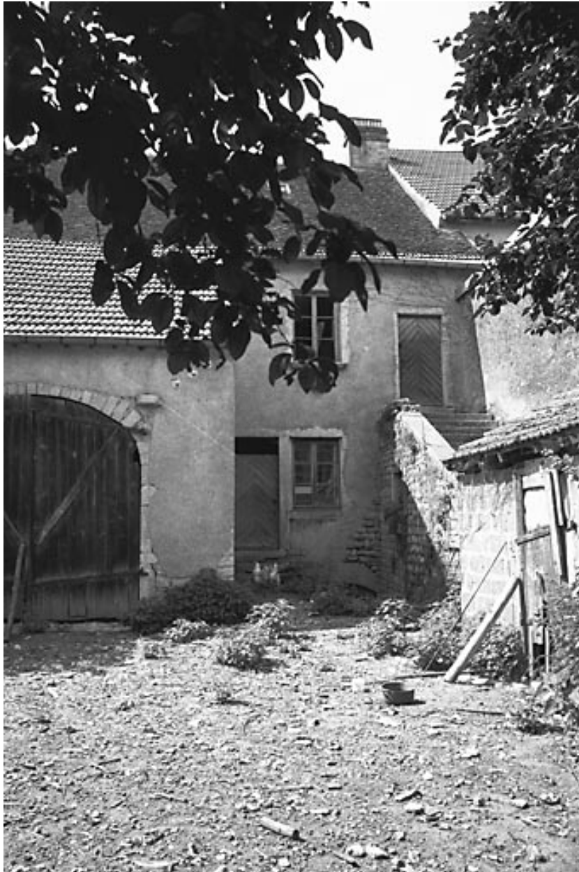
Façade antérieure vue depuis la cour.
