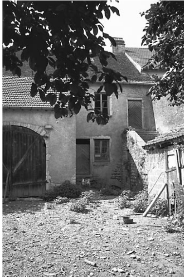
Façade antérieure vue depuis la cour. Phot. Bernard Lardière IVR43_19817000450Z
