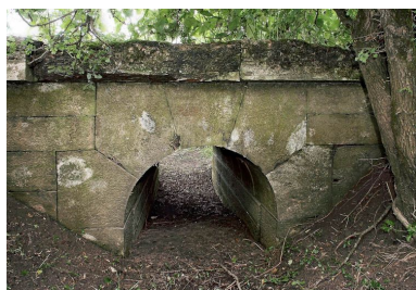
Ponceau, vue rapprochée.
