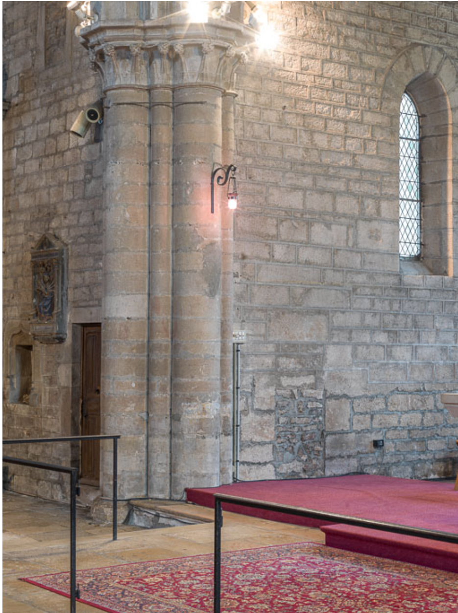
Vue d'un pilier de la croisée.
