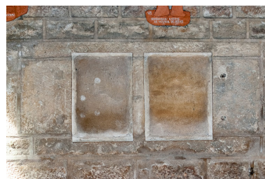
Lavabos murés, mur nord de la nef. Phot. Pierre-Marie Barbe-Richaud IVR26_20152100456NUC2A
