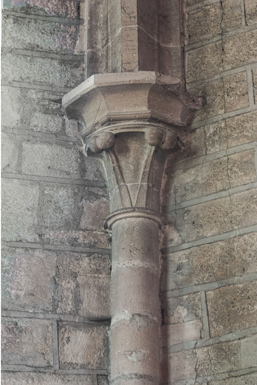
Vue d'un chapiteau du choeur.
