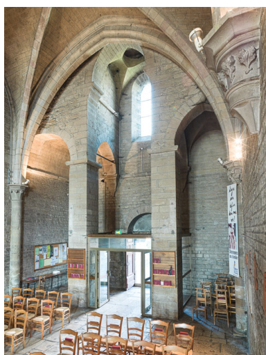
Vue du massif de maçonnerie soutenant le clocher. Phot. Pierre-Marie Barbe-Richaud IVR26_20152100442NUC4A
