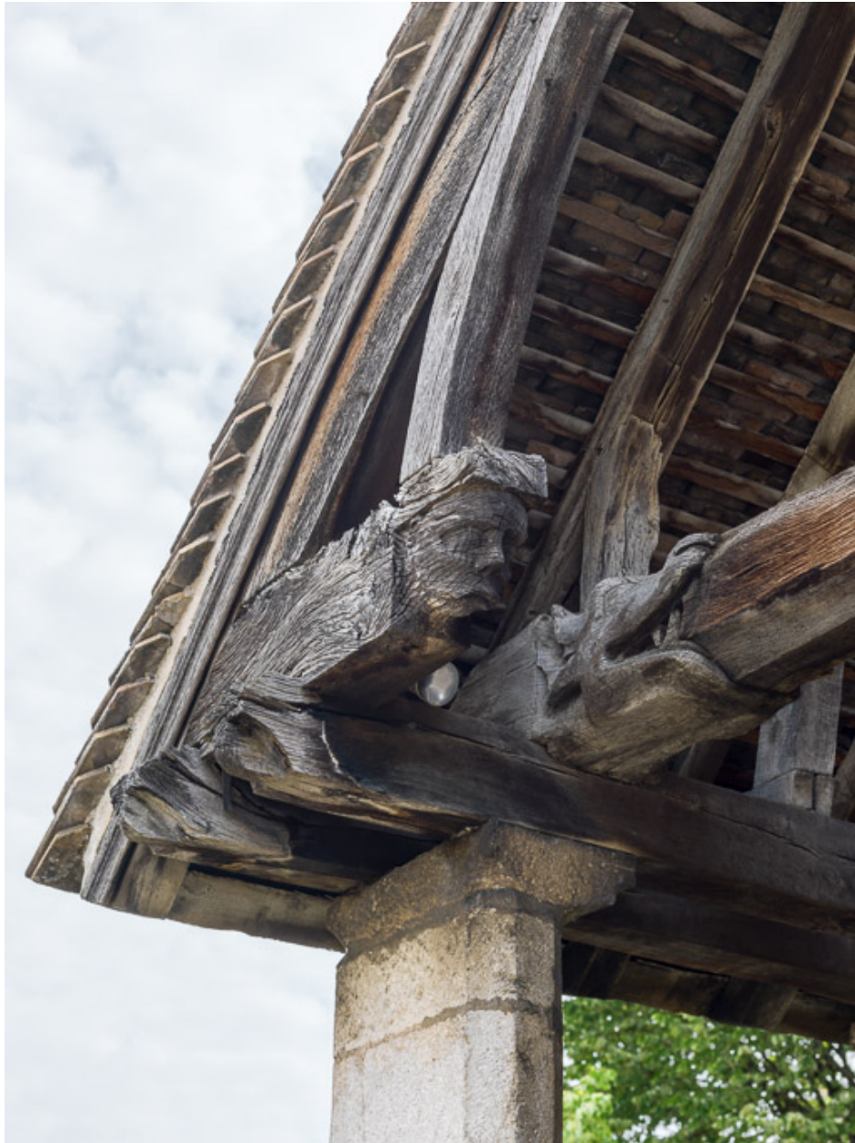
Porche : détail d'un engoulant.
