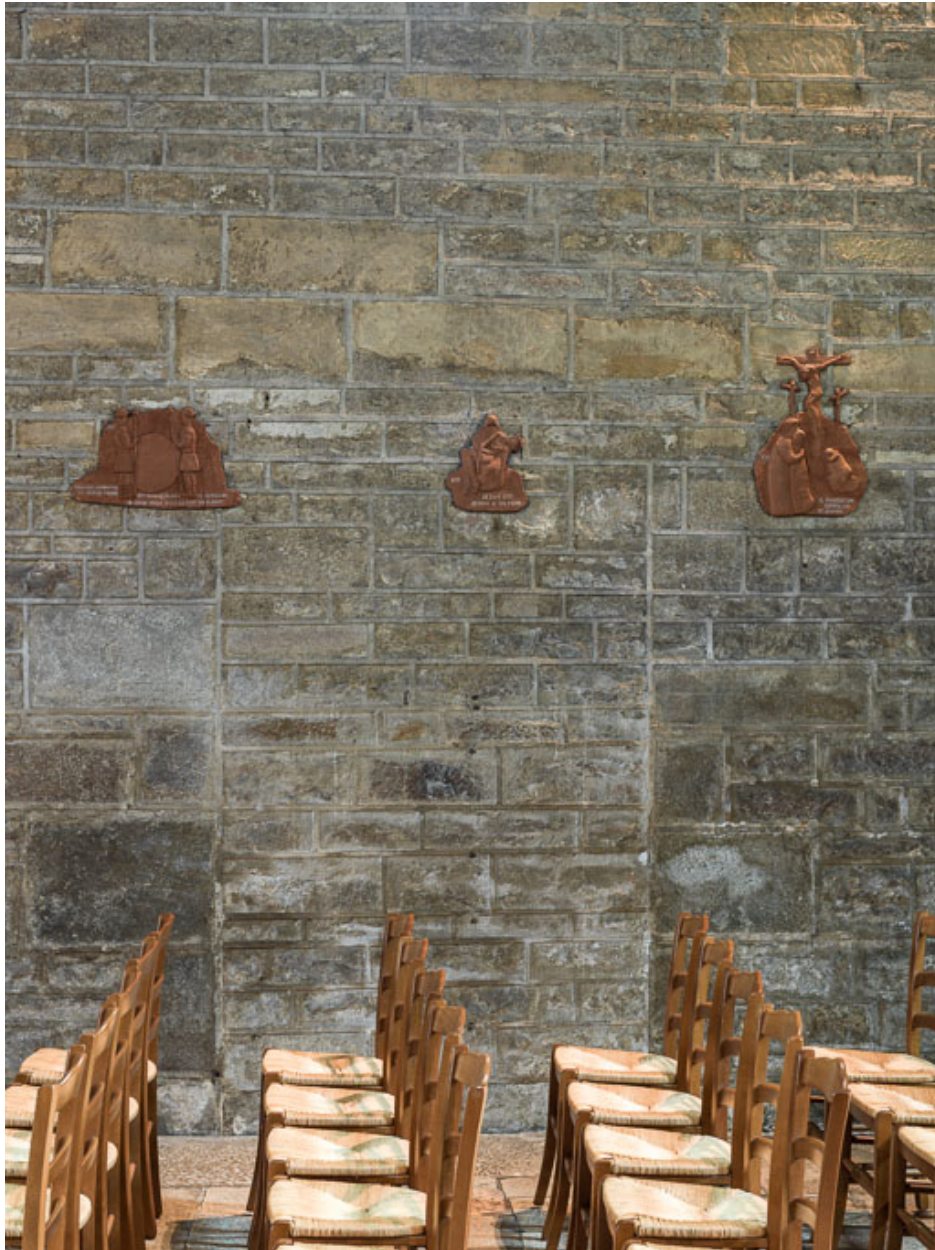
Porte murée, bras nord de la nef.
