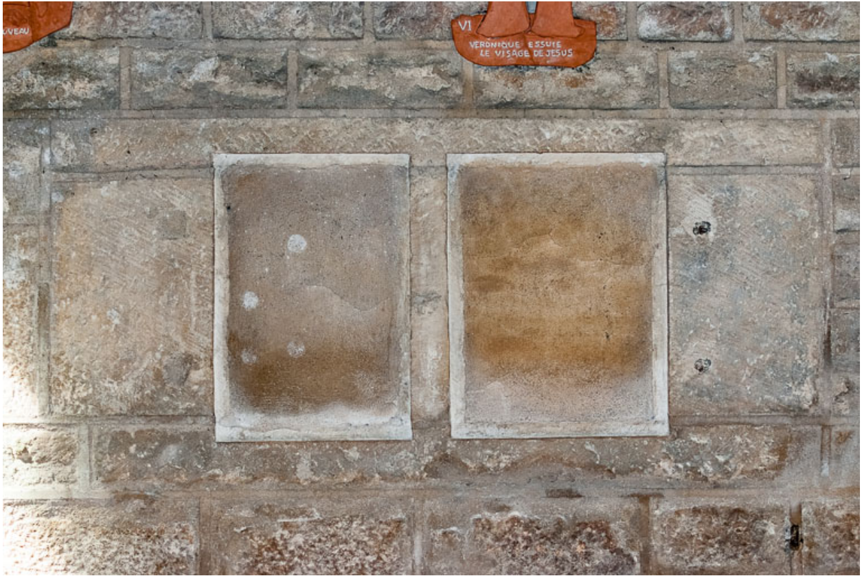
Lavabos murés, mur nord de la nef.
