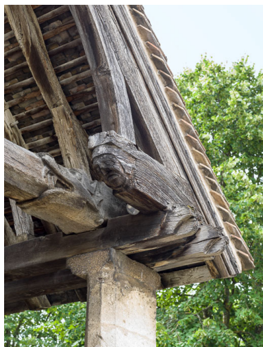
Porche : détail d'un engouant.
