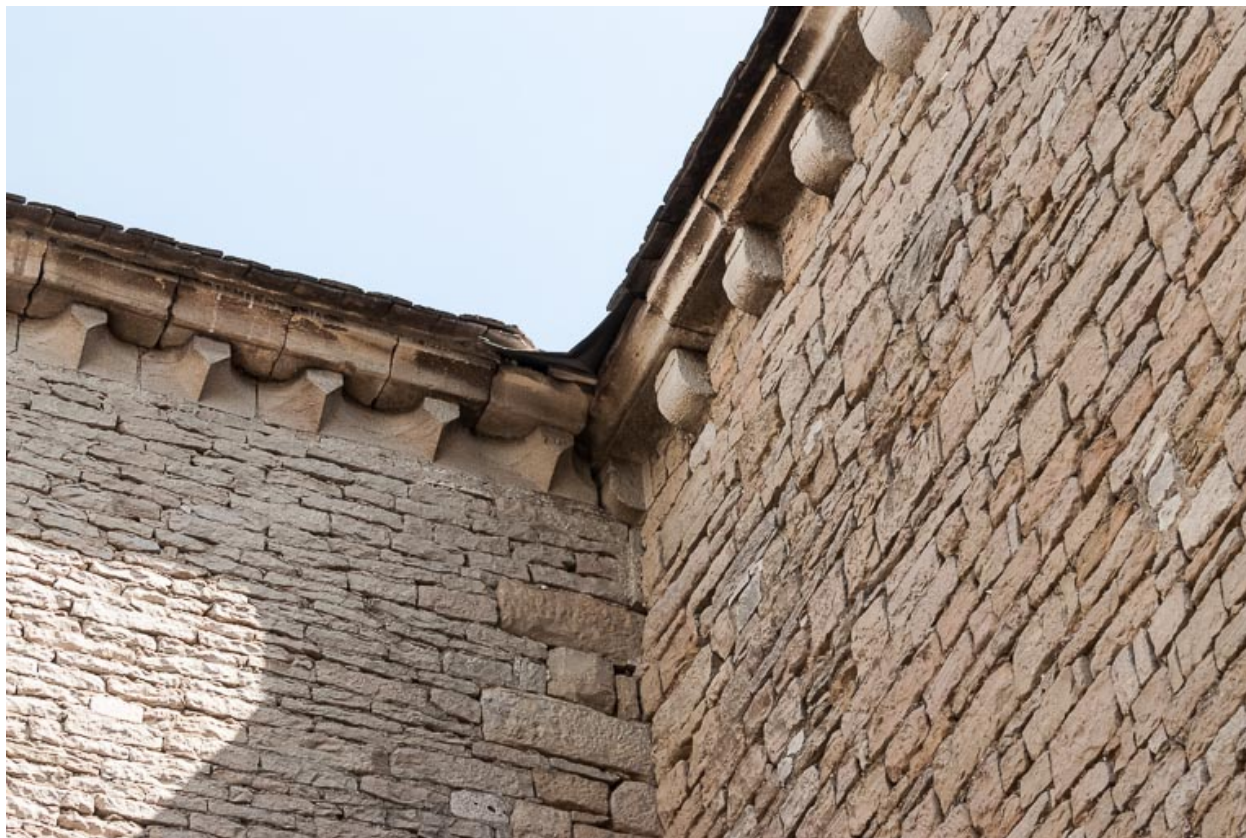
Corniche à modillons, à l'angle de la nef et du bras sud.
