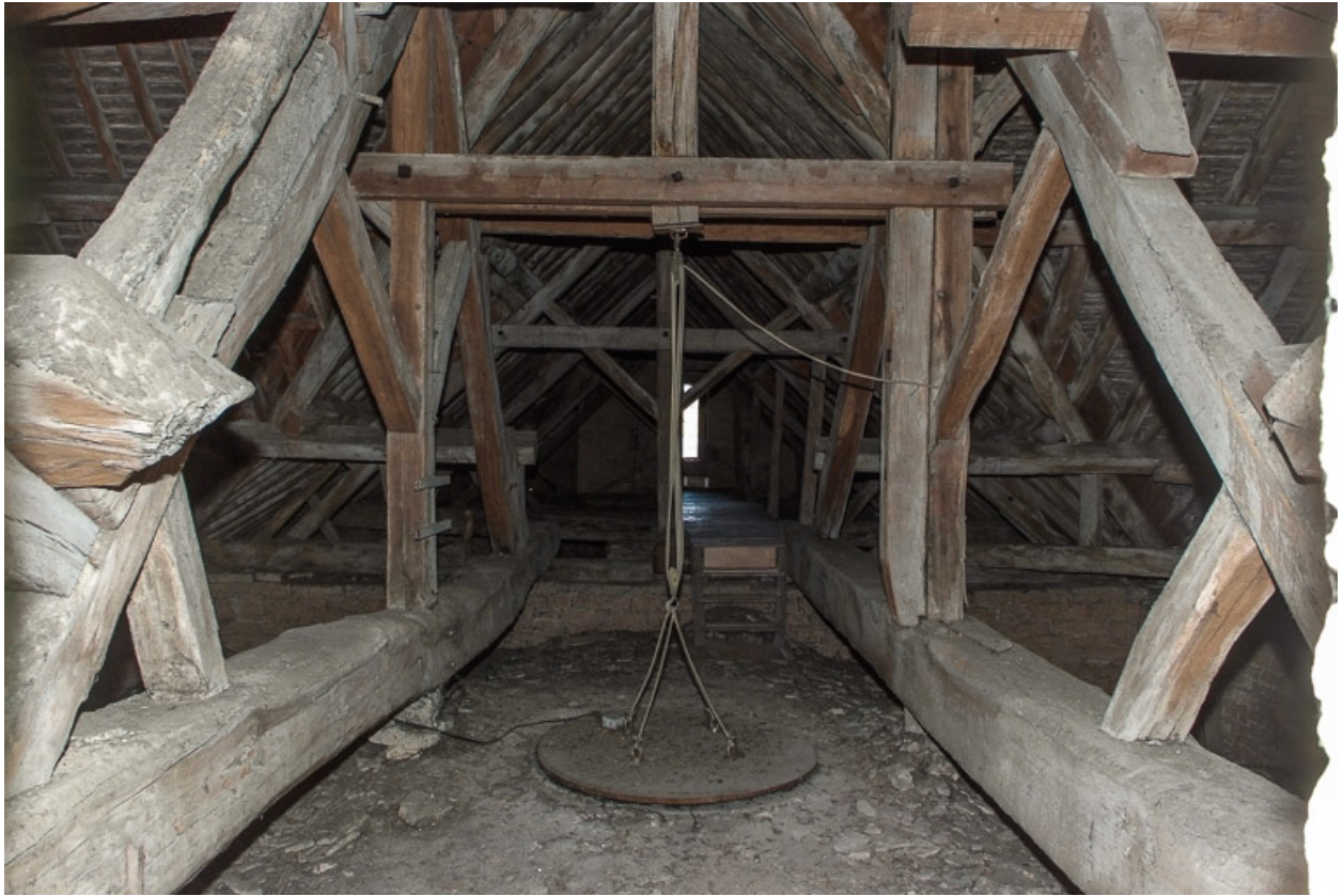
Combles, vue prise au-dessus de la croisée.
