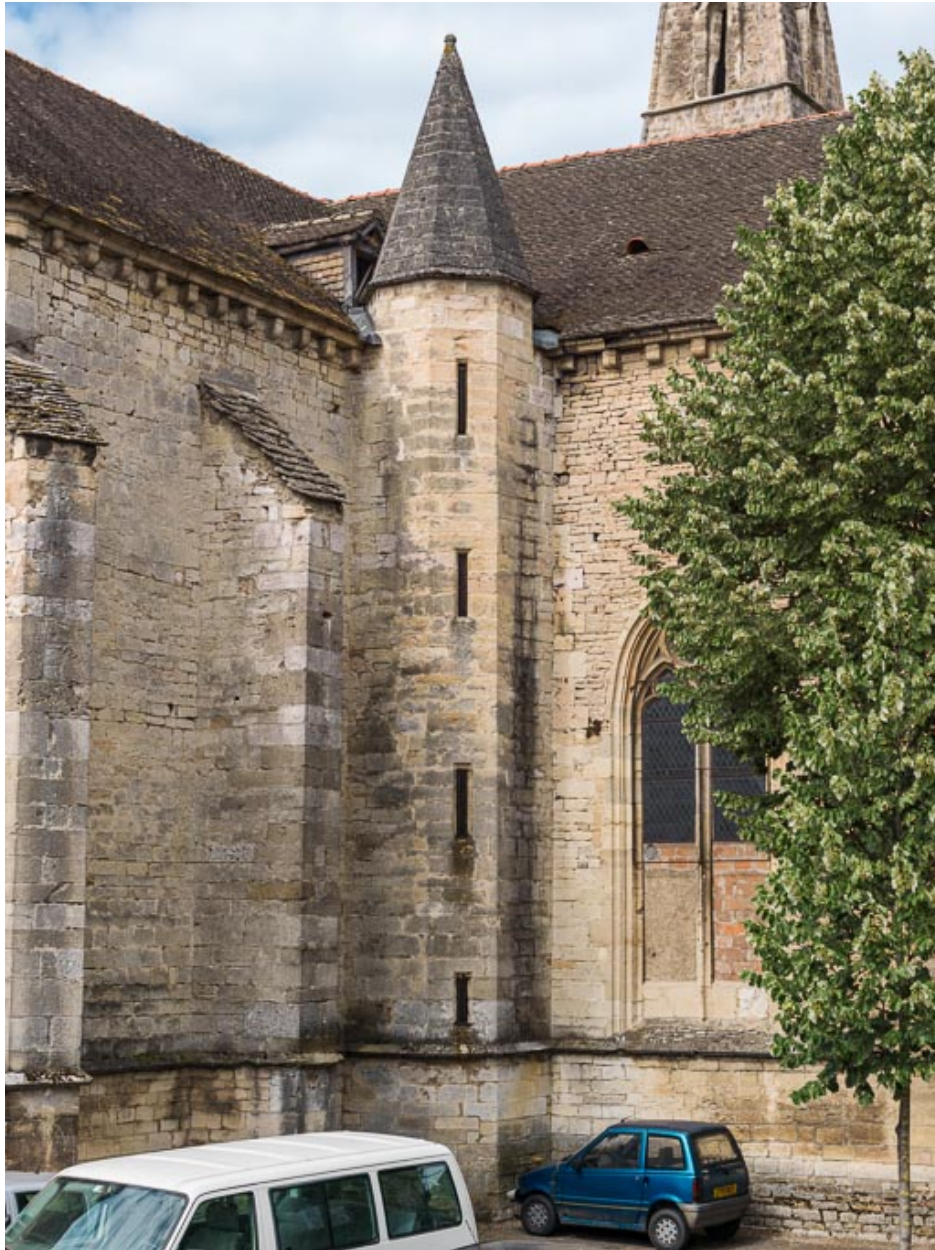
Vue de la tourelle d'escalier.
