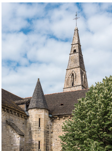
Vue du clocher, depuis l'arrière de l'église. Phot. Pierre-Marie Barbe-Richaud IVR26_20152100428NUC4A
