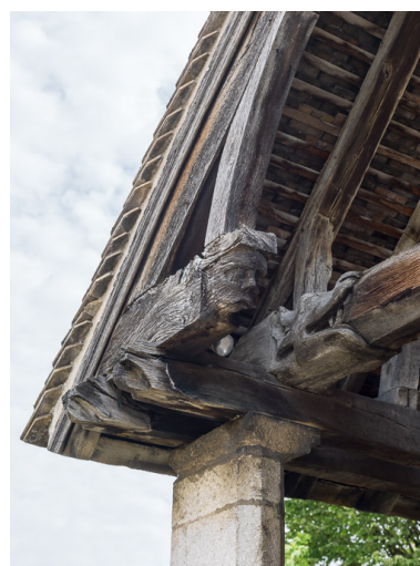
Porche : détail d'un engouant.
