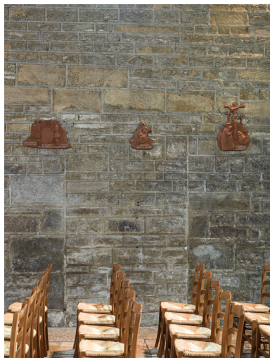
Porte murée, bras nord de la nef. Phot. Pierre-Marie Barbe-Richaud IVR26_20152100457NUC4A
