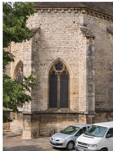
Vue d'une baie du chevet. Phot. Pierre-Marie Barbe-Richaud IVR26_20152100426NUC4A
