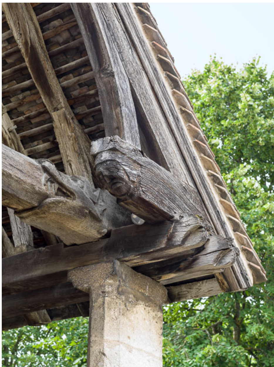
Porche : détail d'un engoulant.
