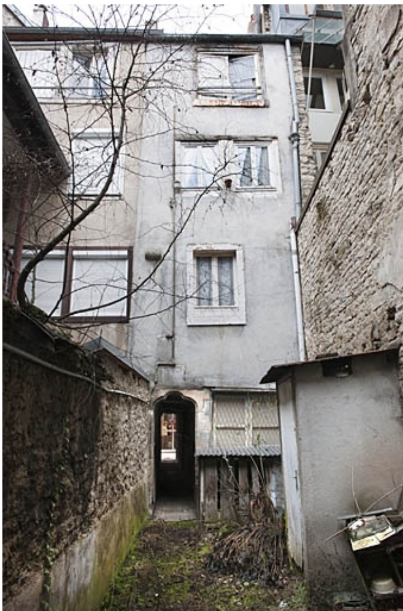
Logis principal : façade postérieure, de face.
