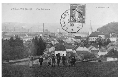
Fraisans (Jura) - Vue générale. Phot. Yves Sancey IVR43_19883900203X
