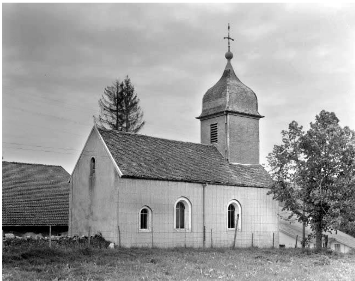
Façades postérieure et latérale gauche.
