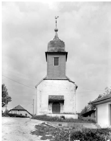
Façade antérieure. Phot. Yves Sancey IVR43_19782500129V
