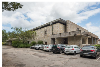
Façade latérale gauche de l'église. Vue de trois quarts. Phot. Pierre-Marie Barbe-Richaud
