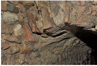
Partie en U de la deuxième galerie : détail de la voûte. Phot. Pierre-Marie Barbe-Richaud IVR26_20107101064NUC2A
