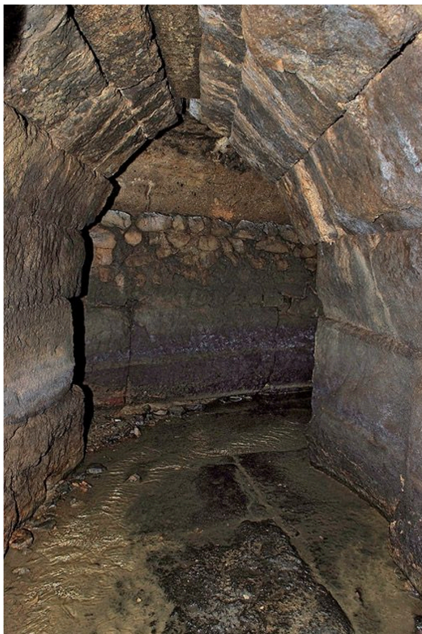
Section reliant les deux galeries.
