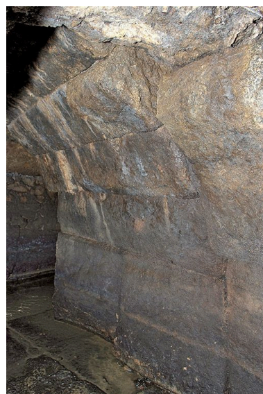
Section reliant les deux galeries. Phot. Pierre-Marie Barbe-Richaud IVR26_20107101042NUC2A
