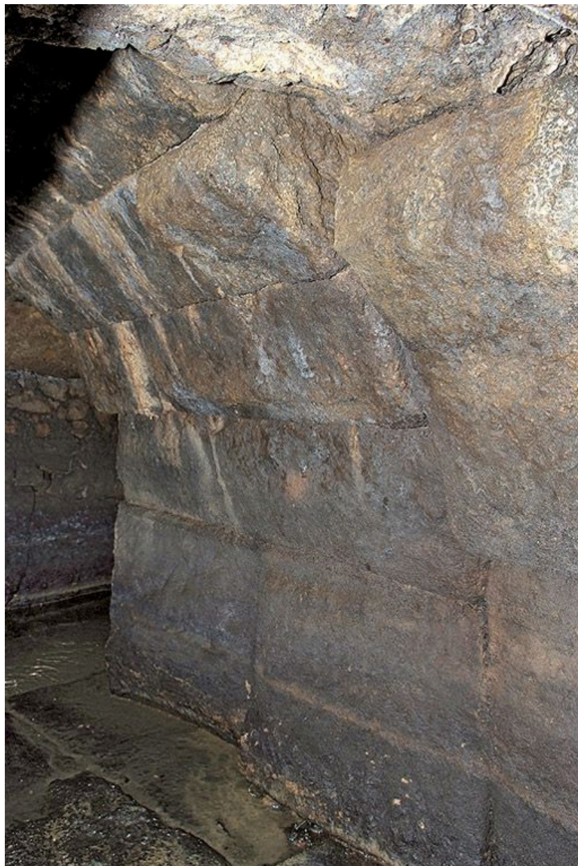
Section reliant les deux galeries.
