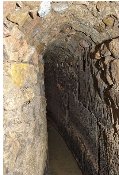
Partie en U de la deuxième galerie : embranchement droit. Phot. Pierre-Marie Barbe-Richaud IVR26_20107101062NUC2A
