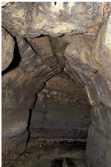
Section reliant les deux galeries. Phot. Pierre-Marie Barbe-Richaud IVR26_20107101045NUC2A
