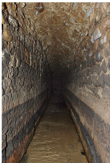
Vue de la deuxième galerie. Phot. Pierre-Marie Barbe-Richaud IVR26_20107101059NUC2A
