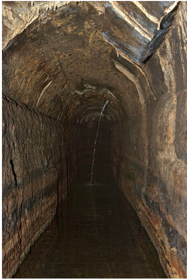
Vue de la deuxième galerie. Phot. Pierre-Marie Barbe-Richaud IVR26_20107101057NUC2A
