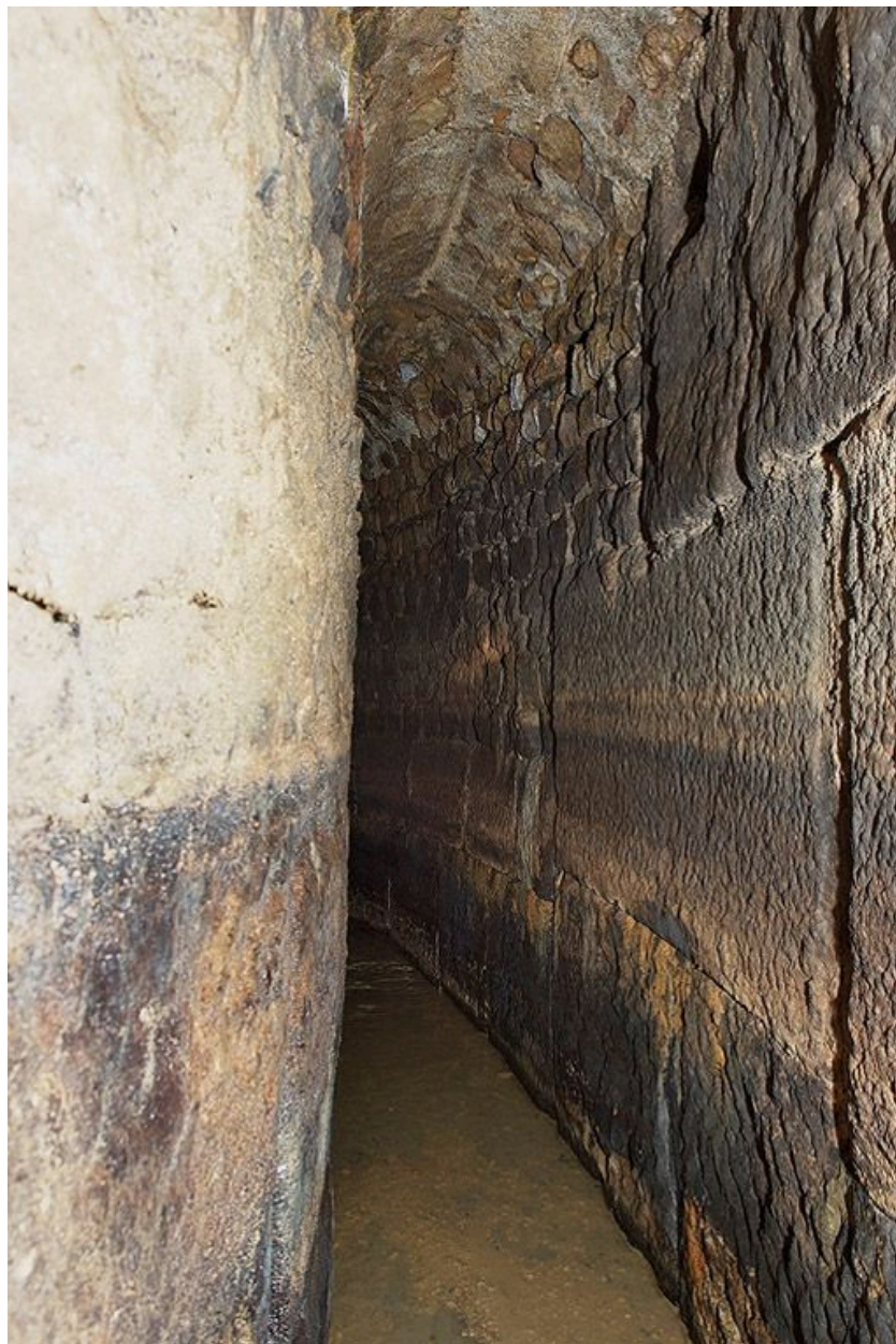
Partie en U de la deuxième galerie : embranchement droit.
