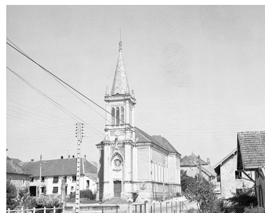
Extérieur : face antérieure. Phot. Yves Sancey IVR43_19752500510X
