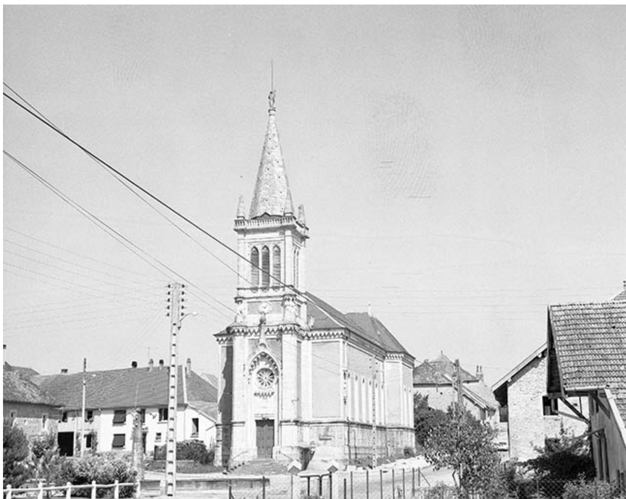
Extérieur : face antérieure.
