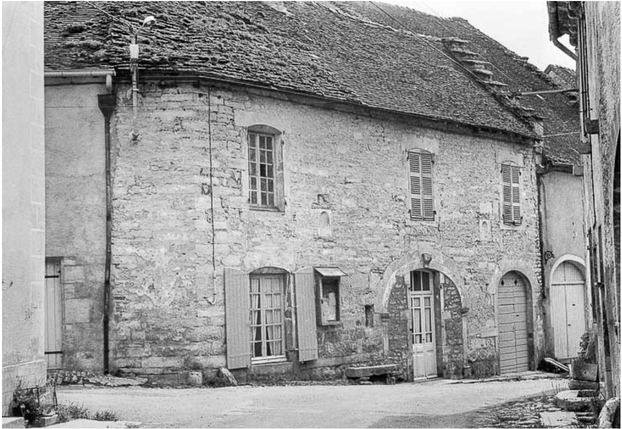
Maison située rue de l'Eglise.
