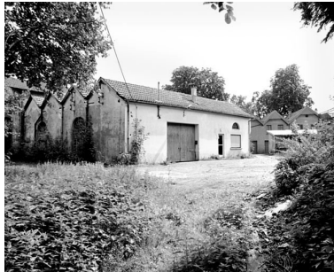
Salle des machines et chaufferie depuis l'ouest.
