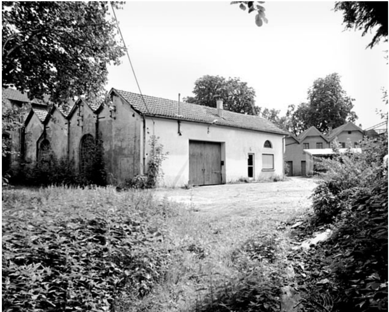
Salle des machines et chaufferie depuis l'ouest.
