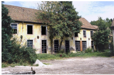
Atelier de réparation depuis la cour.
