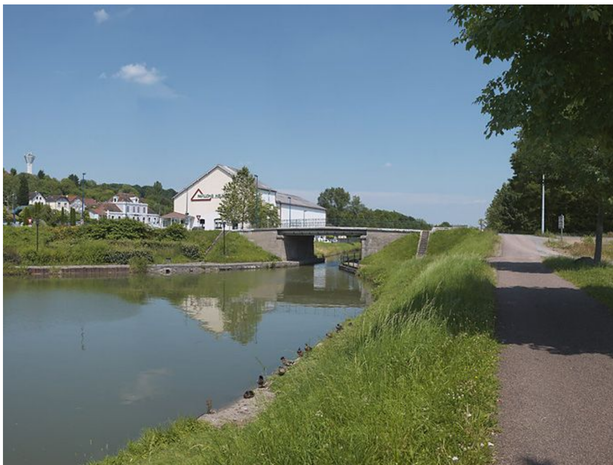
Vue d'ensemble d'aval.
