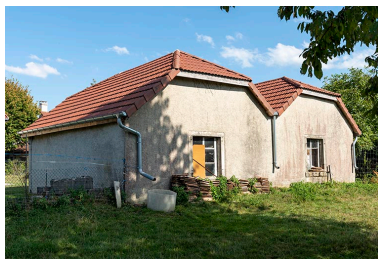
Forges : façade postérieure, de trois quarts gauche. Phot. Sonia Dourlot IVR43_20192501284NUC4A
