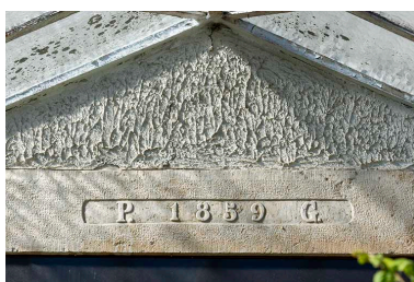
Maison au n° 45 : linteau daté. Phot. Sonia Dourlot IVR43_20192501276NUC4A
