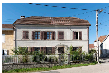
Maison au n° 45. Phot. Sonia Dourlot IVR43_20192501274NUC4A
