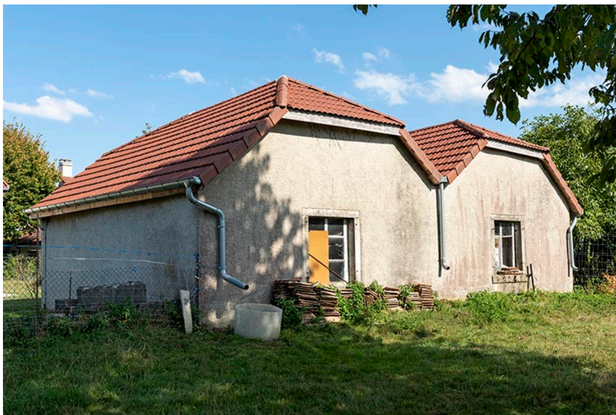
Forges : façade postérieure, de trois quarts gauche.
