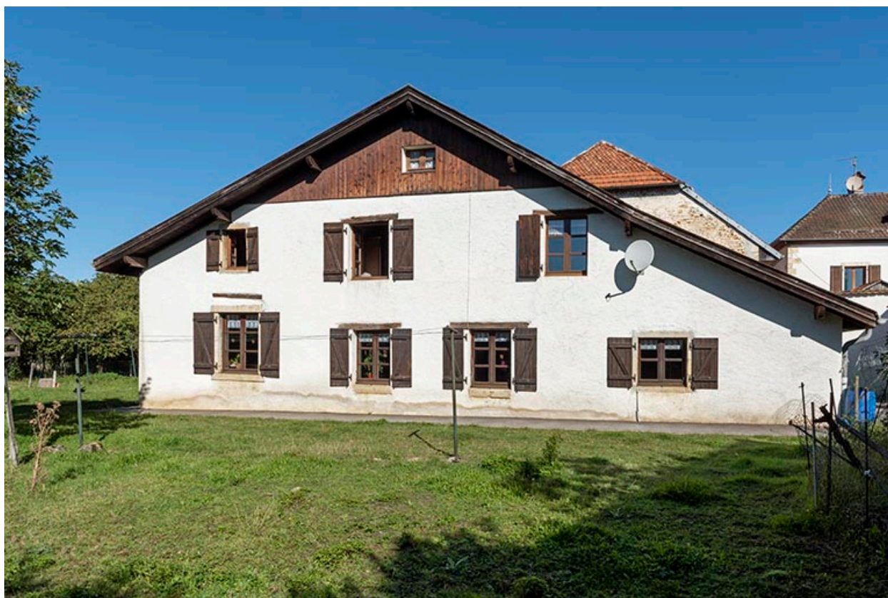
Maison au n° 47 : façade latérale gauche.
