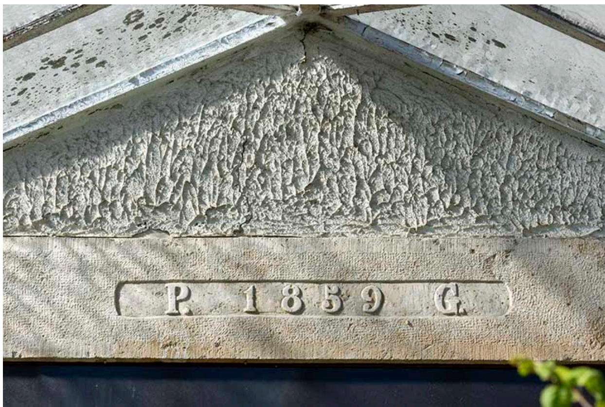
Maison au n° 45 : linteau daté.
