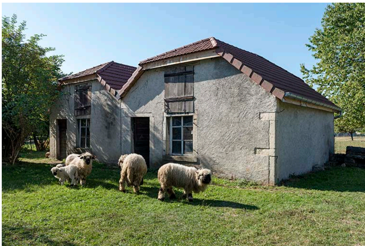
Forges : façade antérieure, de trois quarts droite.
