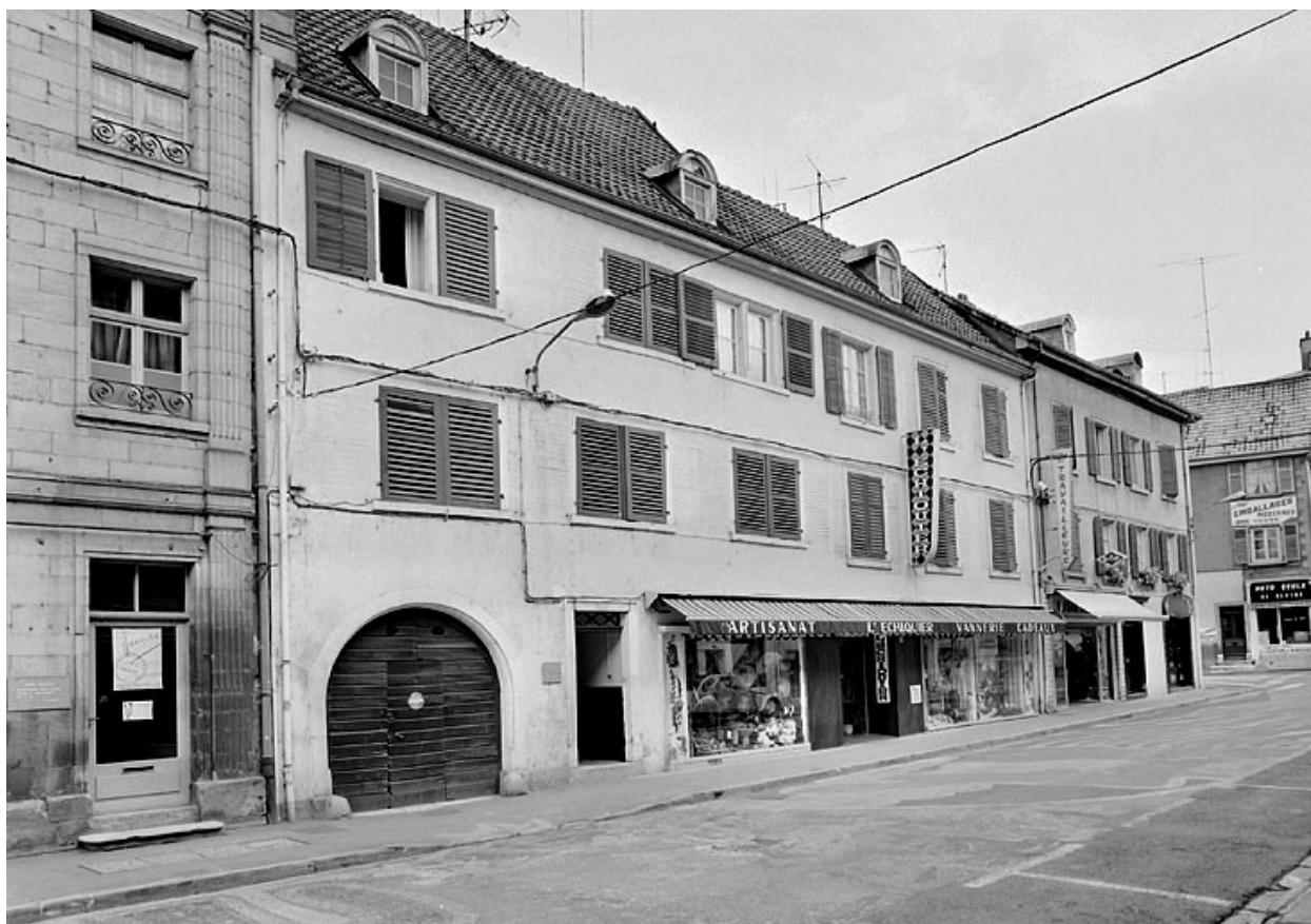
Vue d'ensemble des façades sur rue.
