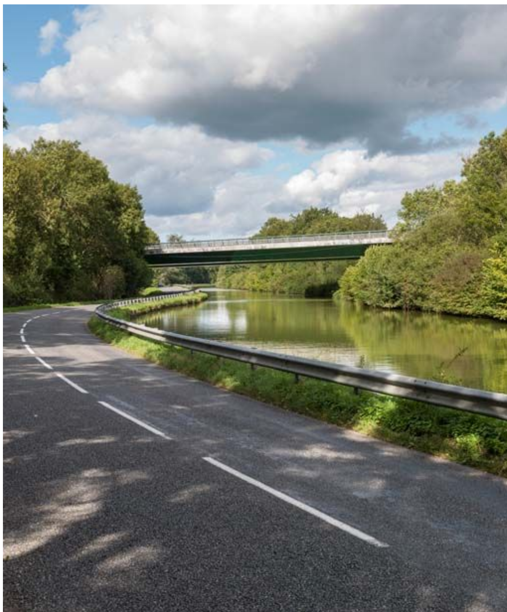
Vue d'ensemble du pont.
