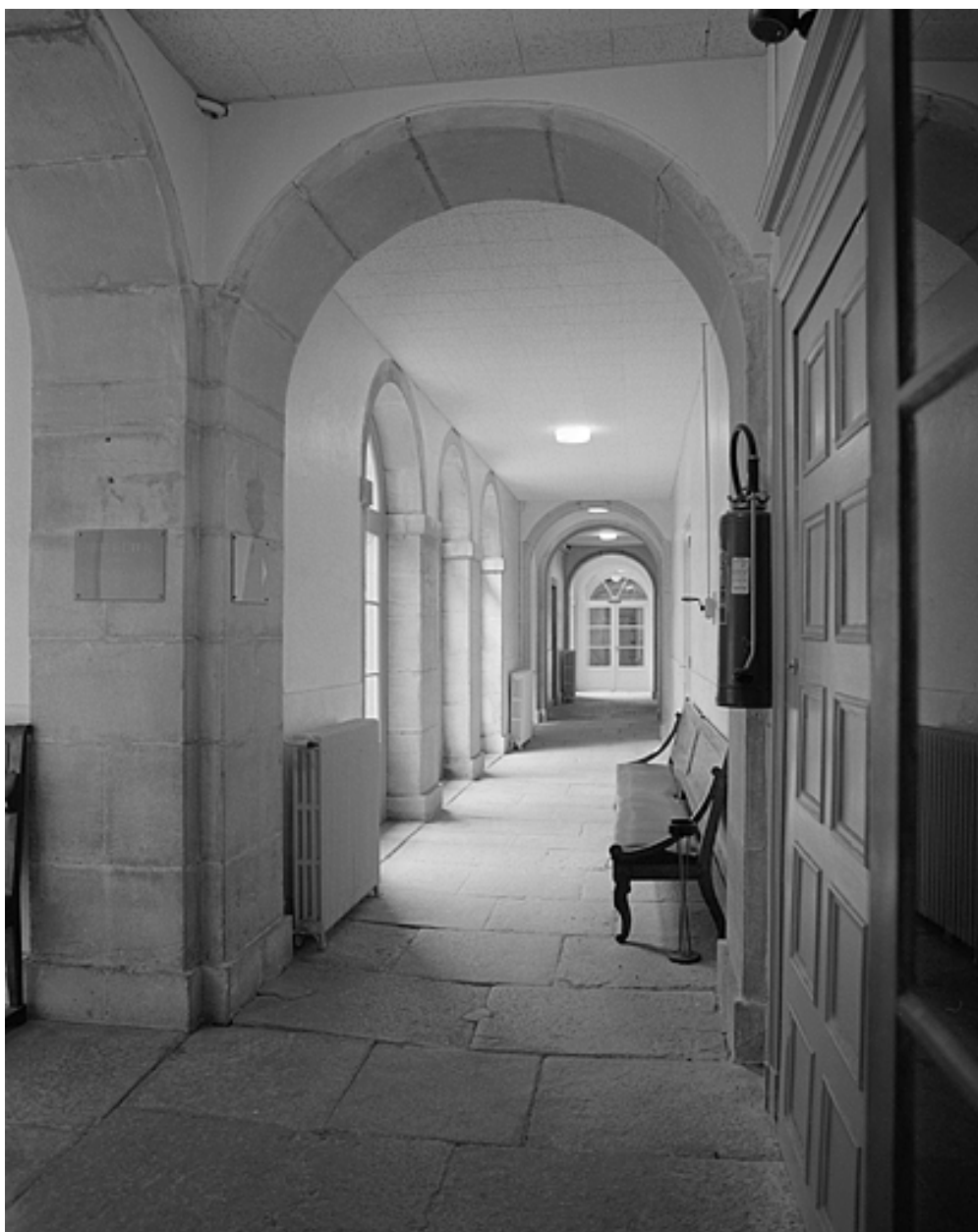
Galerie entourant une des cours intérieures.
